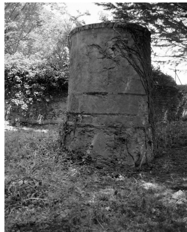
Base en maçonnerie de l'ancienne pompe à eau destinée à alimenter la villa Roche-Grise. Phot. Denis Pillet IVR52_19974402425X
