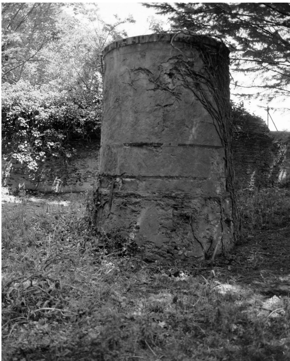
Base en maçonnerie de l'ancienne pompe à eau destinée à alimenter la villa Roche-Grise.
