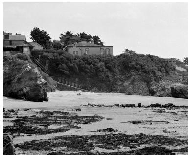
Elévation ouest vue de la plage en contrebas. Phot. Denis Pillet IVR52_19974402423X
