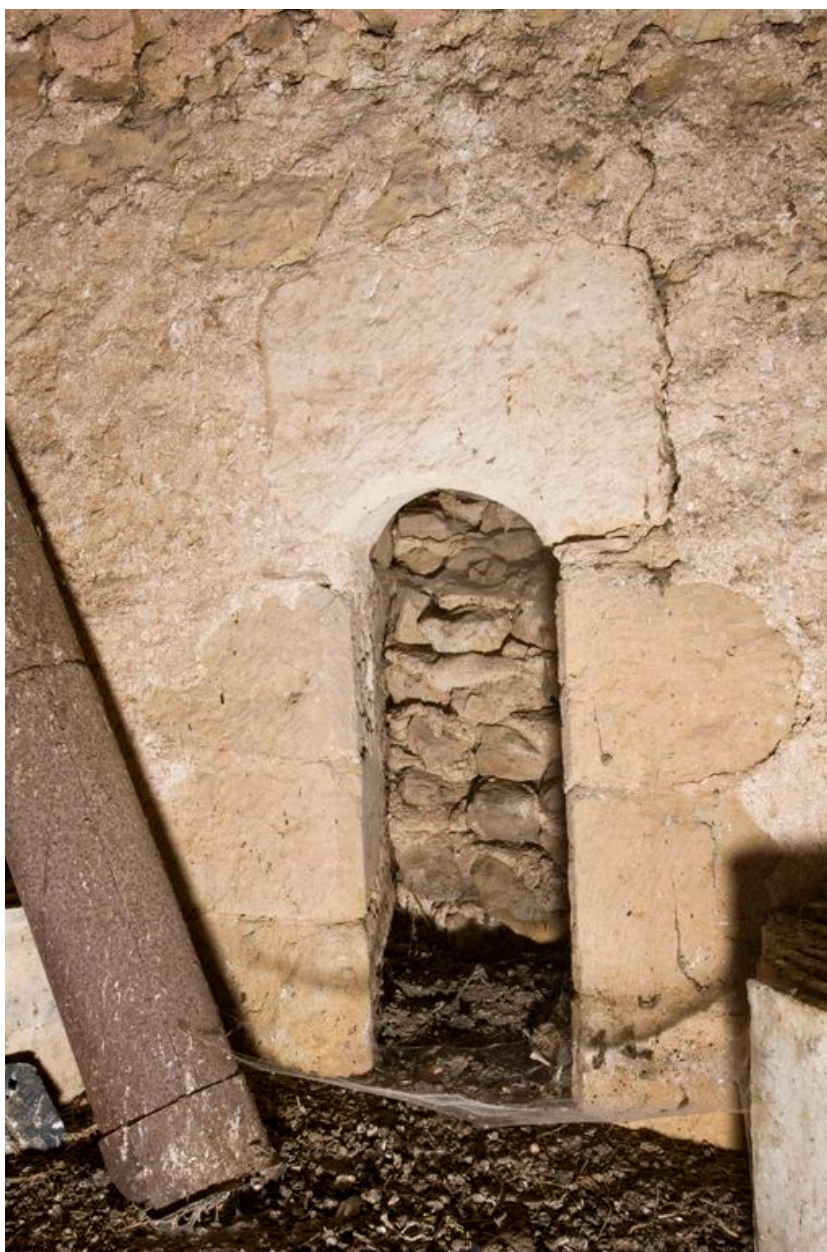
Fenêtre bouchée dans le pignon ouest de la nef, vue depuis le 1er étage de la tour-clocher.
