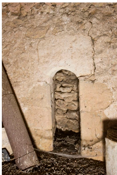
Fenêtre bouchée dans le pignon ouest de la nef, vue depuis le 1er étage de la tour-clocher. Phot. Yves Guillotin IVR52_20117200539NUCA
