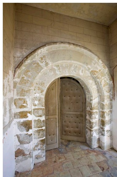
Portail ouest de la nef. Phot. Yves Guillotin IVR52_20117200538NUCA
