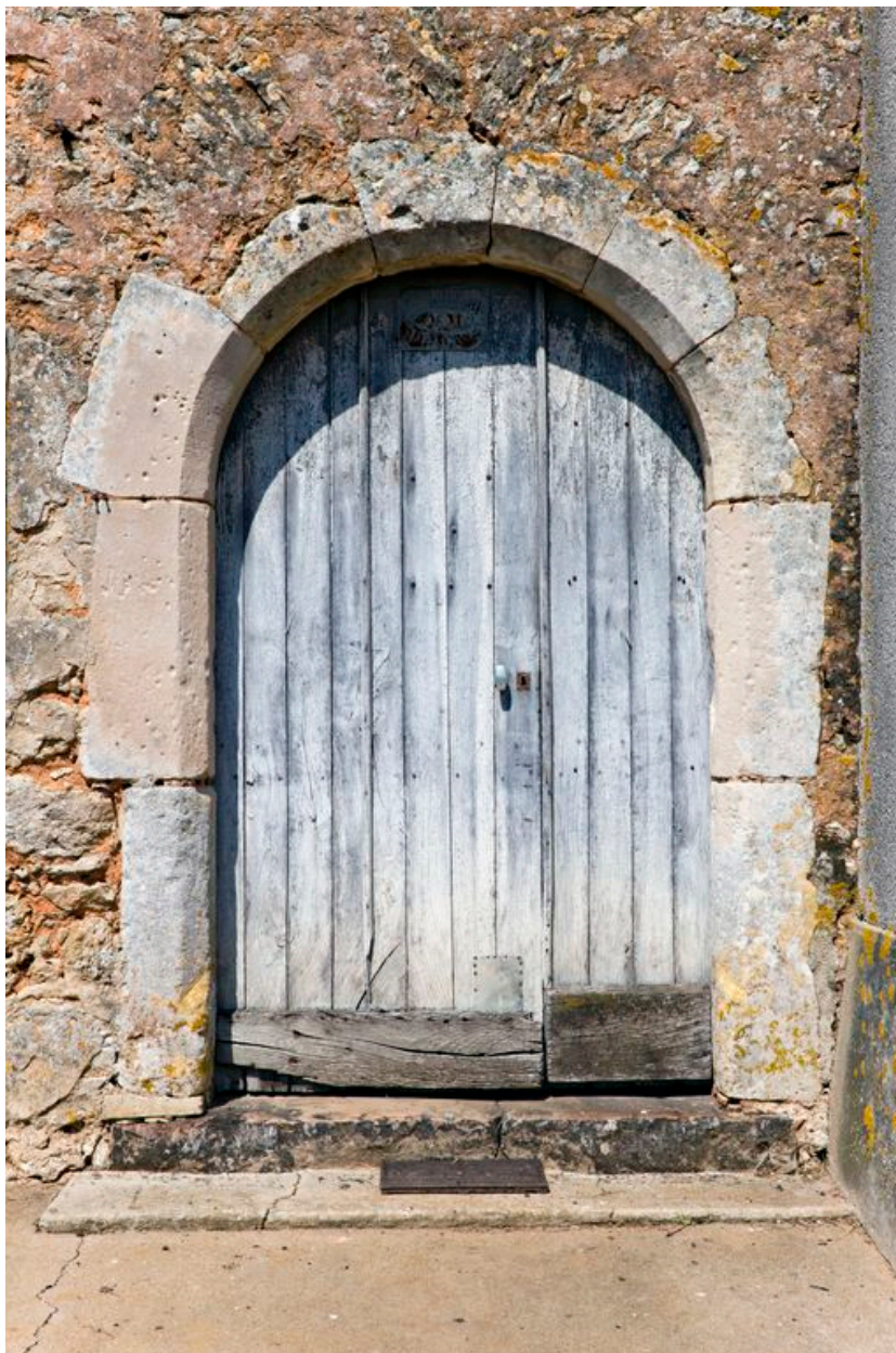
Porte d'entrée de la tour-clocher.
