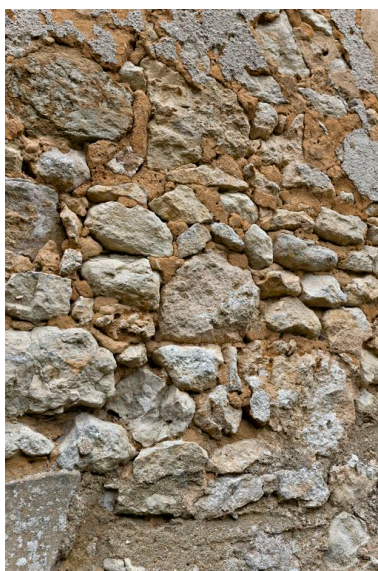
Détail du gros-oeuvre en moellons de calcaire du logis et moulin Phot. Yves Guillotin IVR52_20137200407NUCA
