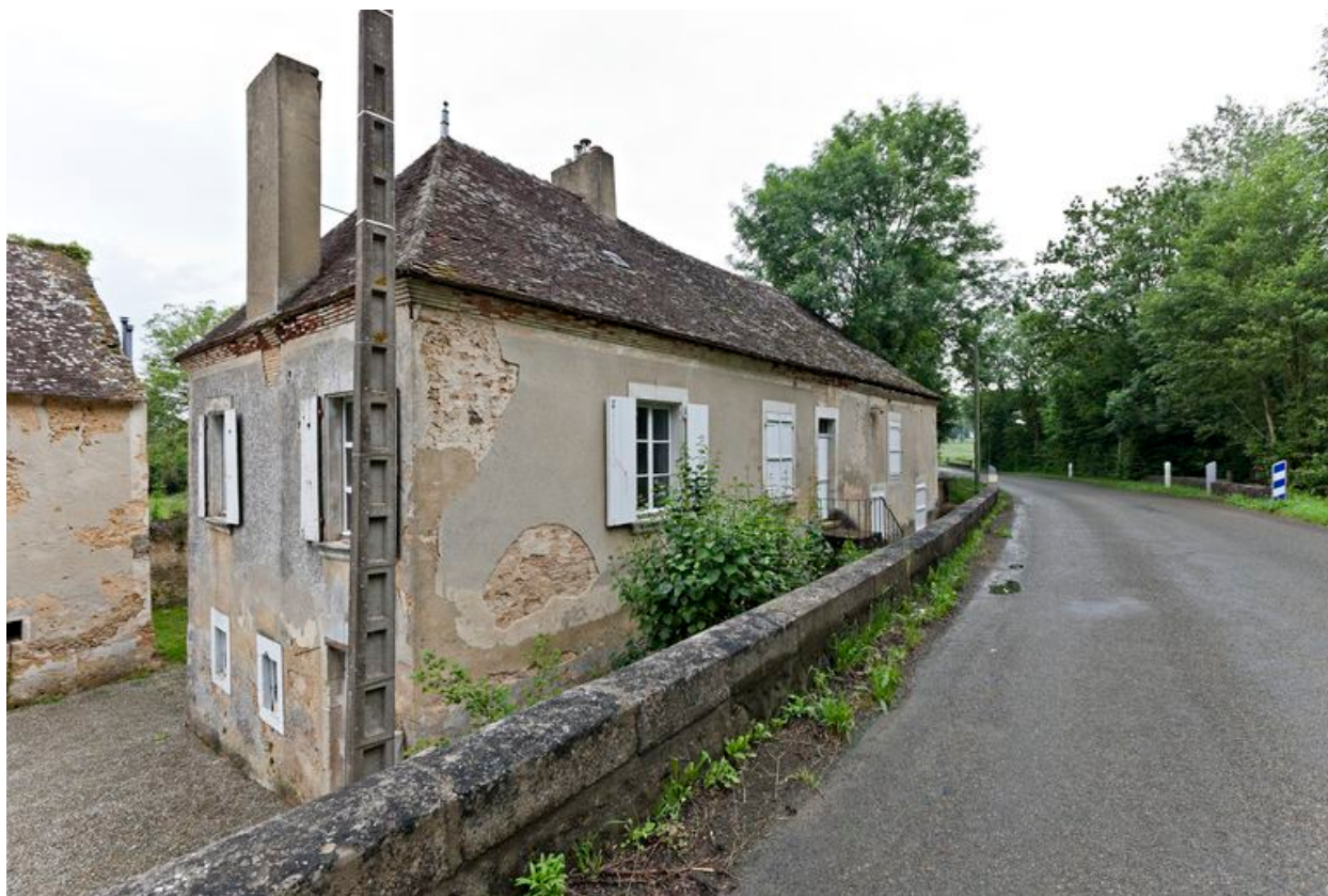
Le logis et moulin vu de la digue de retenue
