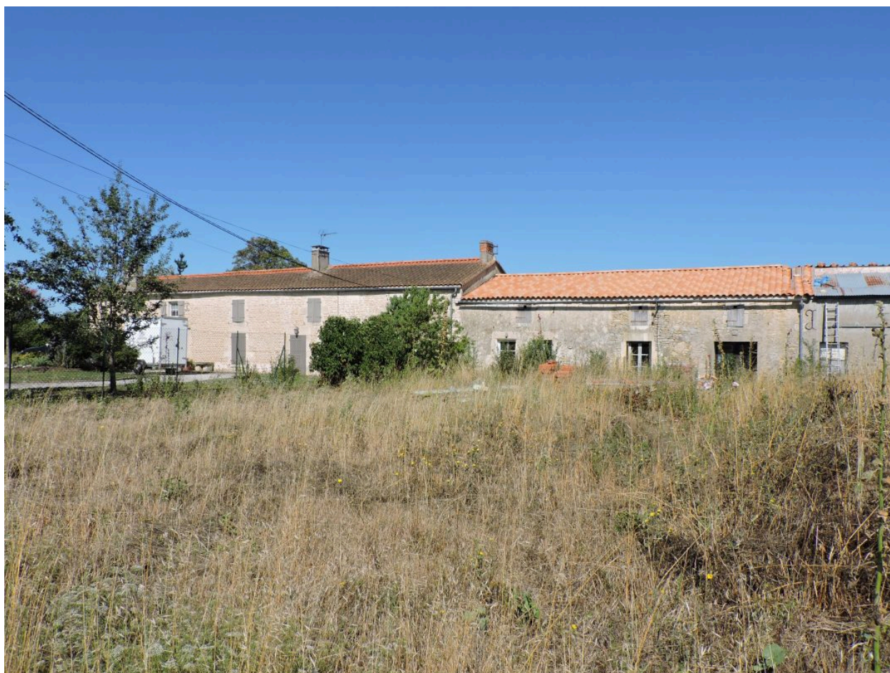
Le logis, à gauche, et le second logement, à droite, vus depuis l'est.
