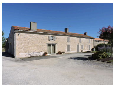
Le logis vu depuis le sud.
