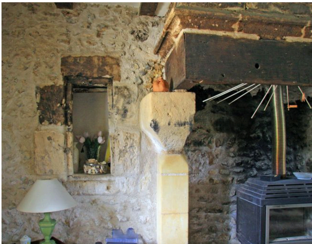
Les dépendances : niche à étagère et détail du linteau.
