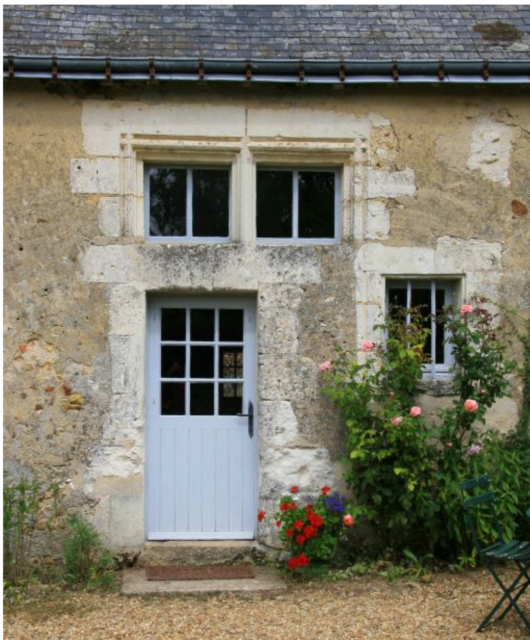
La maison : vestiges d'une croisée en pierre (fin XVe siècle).
