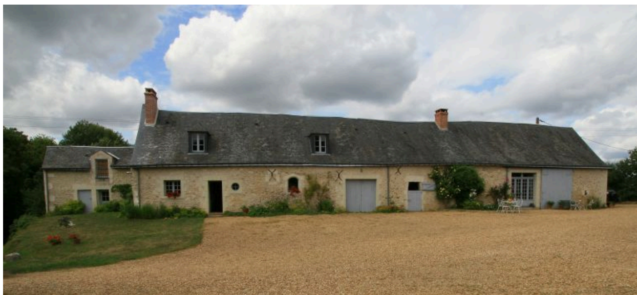
Les dépendances, façade sur cour : à gauche, vestige d'une maison.
