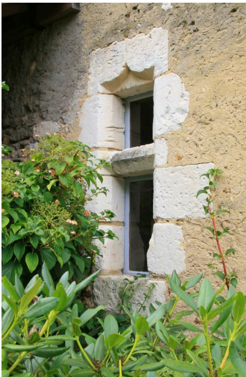
La maison : demi-baie à traverse.
