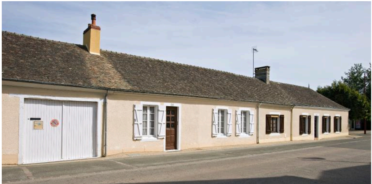
Vue d'ensemble des maisons 33 à 35 rue Principale
