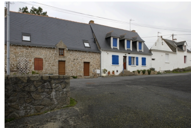
Vue d'ensemble depuis le sud-ouest. Phot. Denis Pillet IVR52_20084400086NUCA
