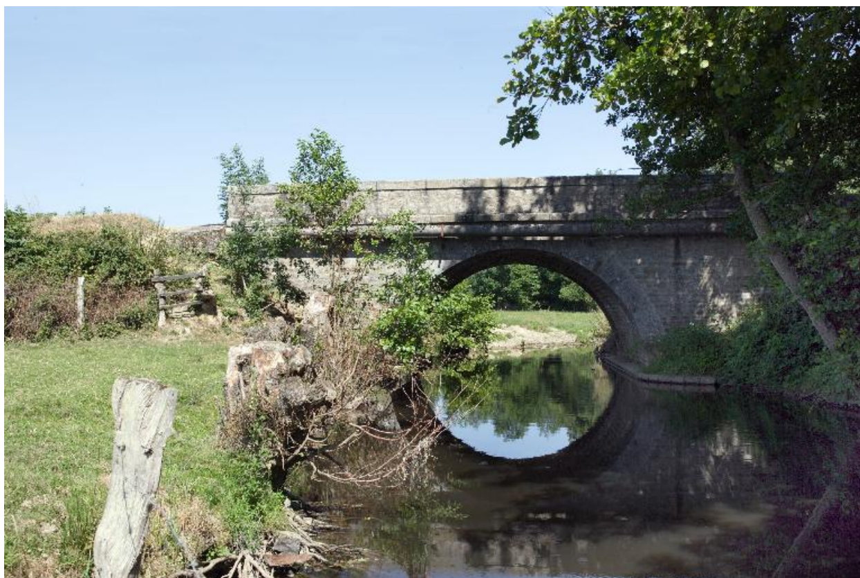
Vue depuis l'aval à l'ouest.
