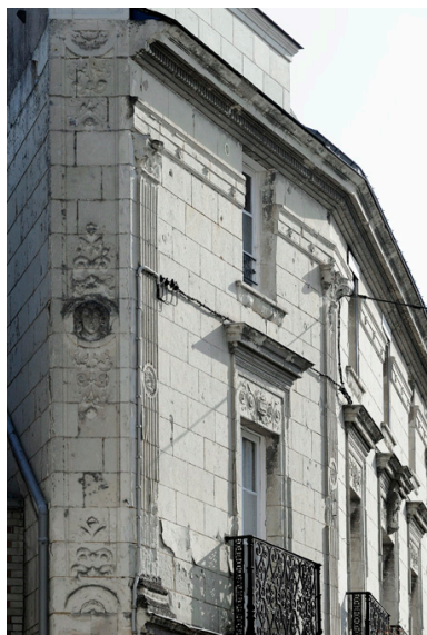
Détail de la façade (2) Phot. Bruno Rousseau, Phot. Youenn Communeau IVR52_20114900664NUCA
