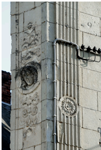
Décor : pilastre cannelé, mascaron, fleuron, rinceaux Phot. Bruno Rousseau, Phot. Youenn Communeau IVR52_20114900666NUCA
