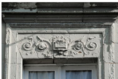
Dessus de fenêtre à décor de rinceaux et cartouche portant la date (1865) Phot. Bruno Rousseau, Phot. Youenn Communeau IVR52_20114900667NUCA
