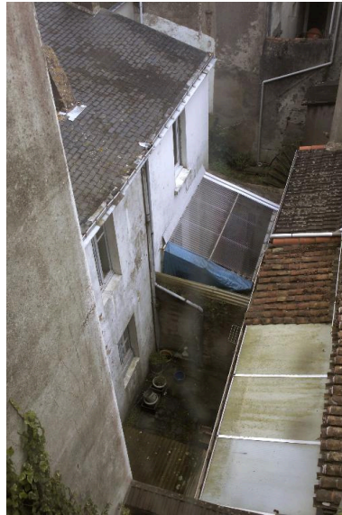
Vue de la cour et de la façade postérieure de la maison n ° 23, n° 24 quai Sadi-Carnot. Phot. Denis Pillet IVR52_20034400511NUCA
