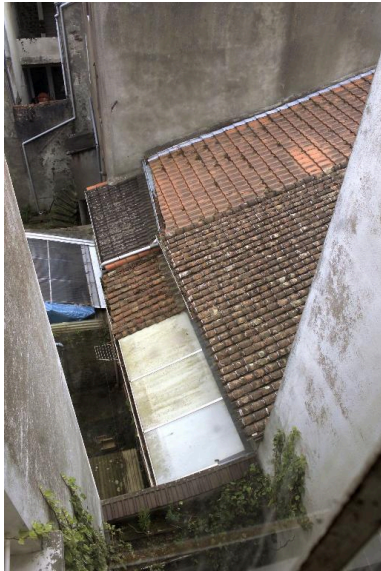
Vue partielle de la toiture depuis l'escalier de la maison n° 54. Phot. Denis Pillet IVR52_20034400512NUCA
