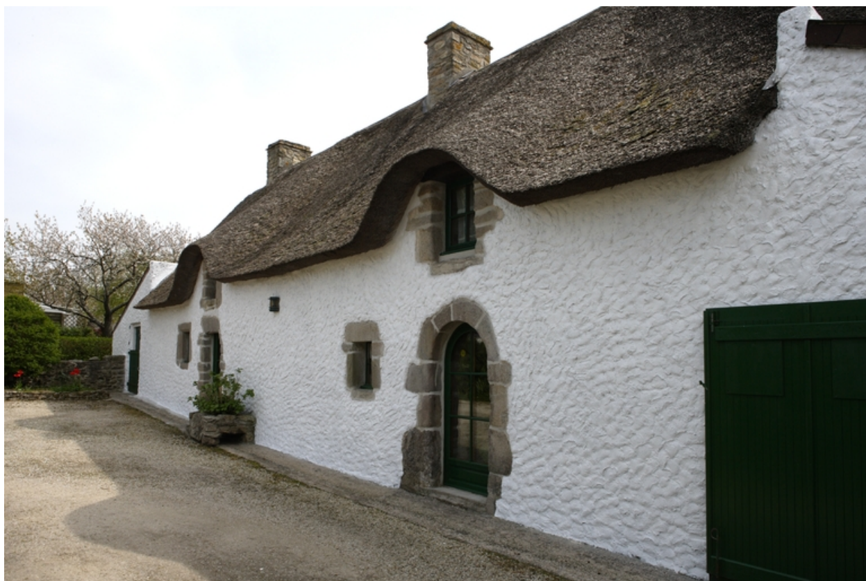
Vue de la façade sud.
