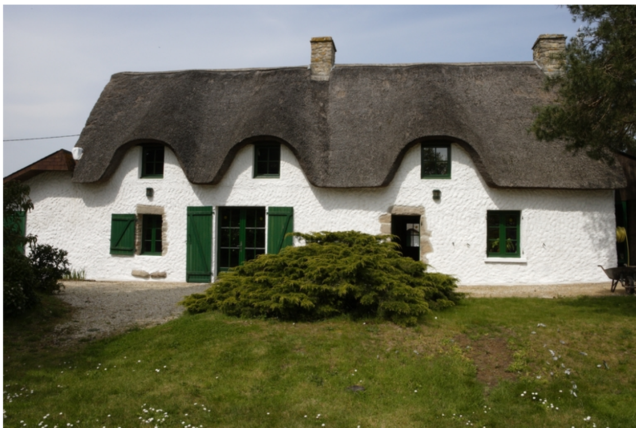
Vue de la façade sud.
