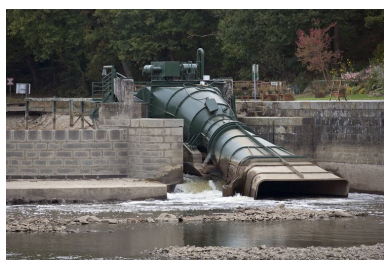
La micro-centrale hydroélectrique vue de trois-quarts depuis l'aval, pendant les écoures de 2009. Phot. Yves Guillotin IVR52_20095300454NUCA
