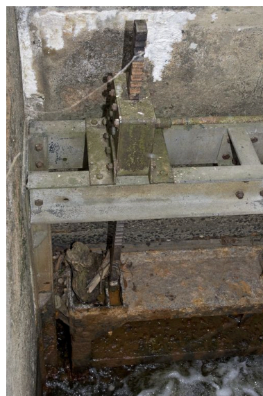
Détail de la vanne et des crémaillère d'une des portes de l'écluse pendant les écoures de 2009. Phot. Yves Guillotin IVR52_20095300456NUCA
