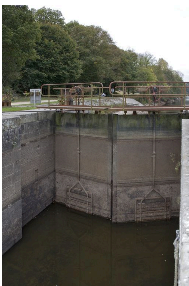
Le sas de l'écluse et la porte aval vus depuis le nord, pendant les écoures de 2009. Phot. Yves Guillotin IVR52_20095300457NUCA
