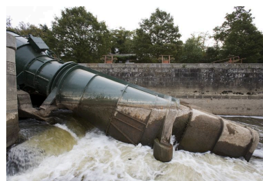
La micro-centrale hydroélectrique vue de côté, pendant les écoures de 2009. Phot. Yves Guillotin IVR52_20095300453NUCA
