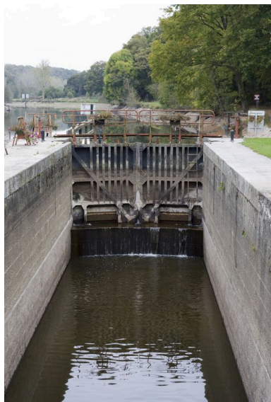
Le sas de l'écluse et la porte amont vus depuis le sud, pendant les écourues de 2009. Phot. Yves Guillotin IVR52_20095300445NUCA
