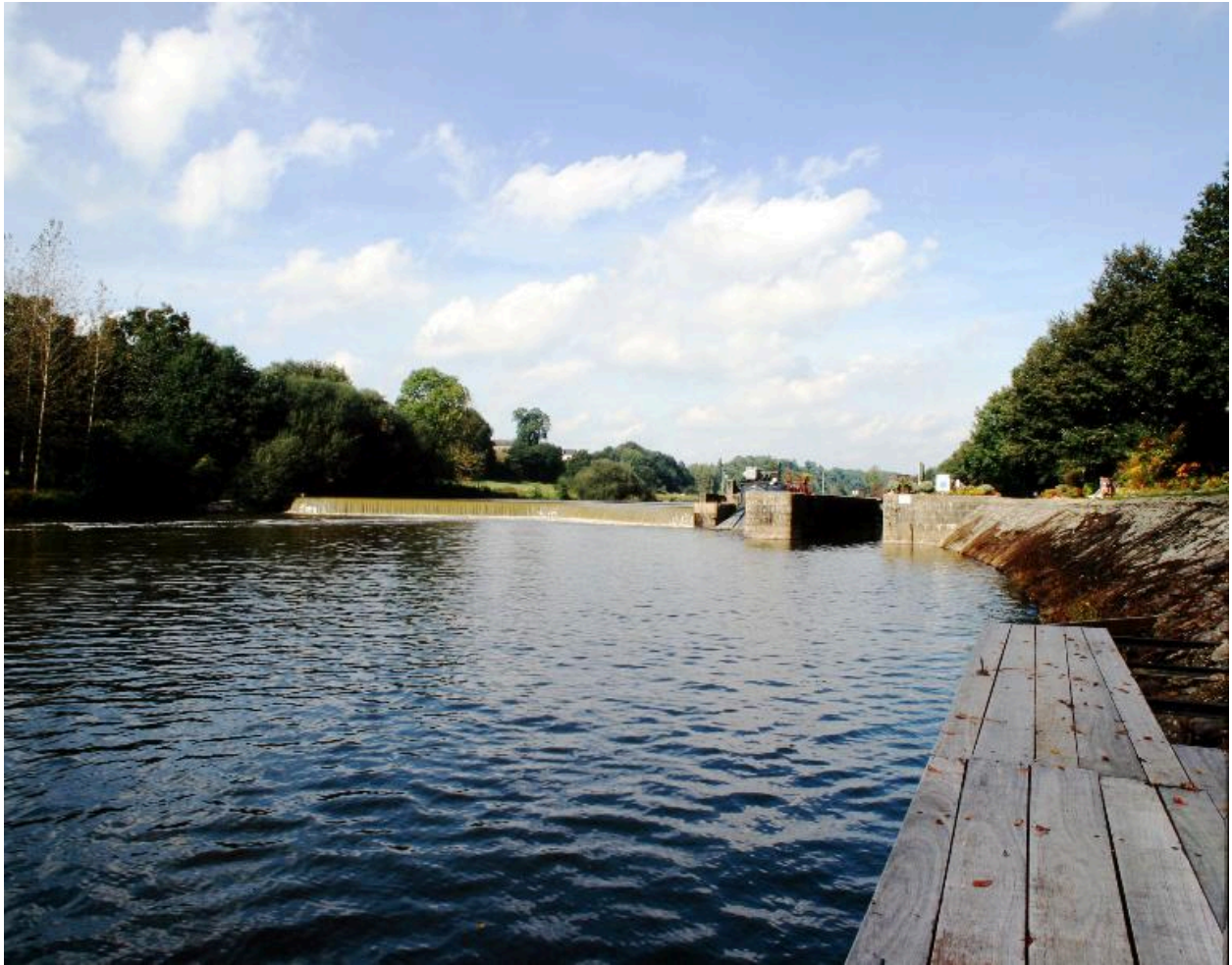
Vue d'ensemble du site d'écluse depuis le ponton situé rive gauche en aval : barrage, centrale hydroélectrique, écluse.
