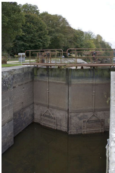
Le sas de l'écluse et la porte aval vus depuis le nord, pendant les écourues de 2009. Phot. Yves Guillotin IVR52_20095300457NUCA
