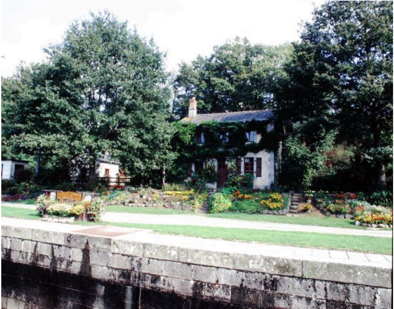
La maison éclusière. A gauche, le transformateur électrique et le fournil.
