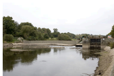
Vue d'ensemble du site d'écluse depuis la rive gauche en aval pendant les écoures de 2009 : barrage, centrale hydroélectrique, écluse. Phot. Yves Guillotin IVR52_20095300444NUCA
