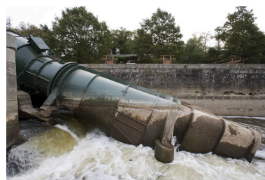
La micro-centrale hydroélectrique vue de côté, pendant les écourues de 2009. Phot. Yves Guillotin IVR52_20095300453NUCA
