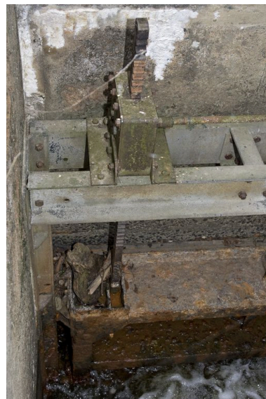
Détail de la vanne et des crémaillères d'une des portes de l'écluse pendant les écourues de 2009. Phot. Yves Guillotin IVR52_20095300456NUCA
