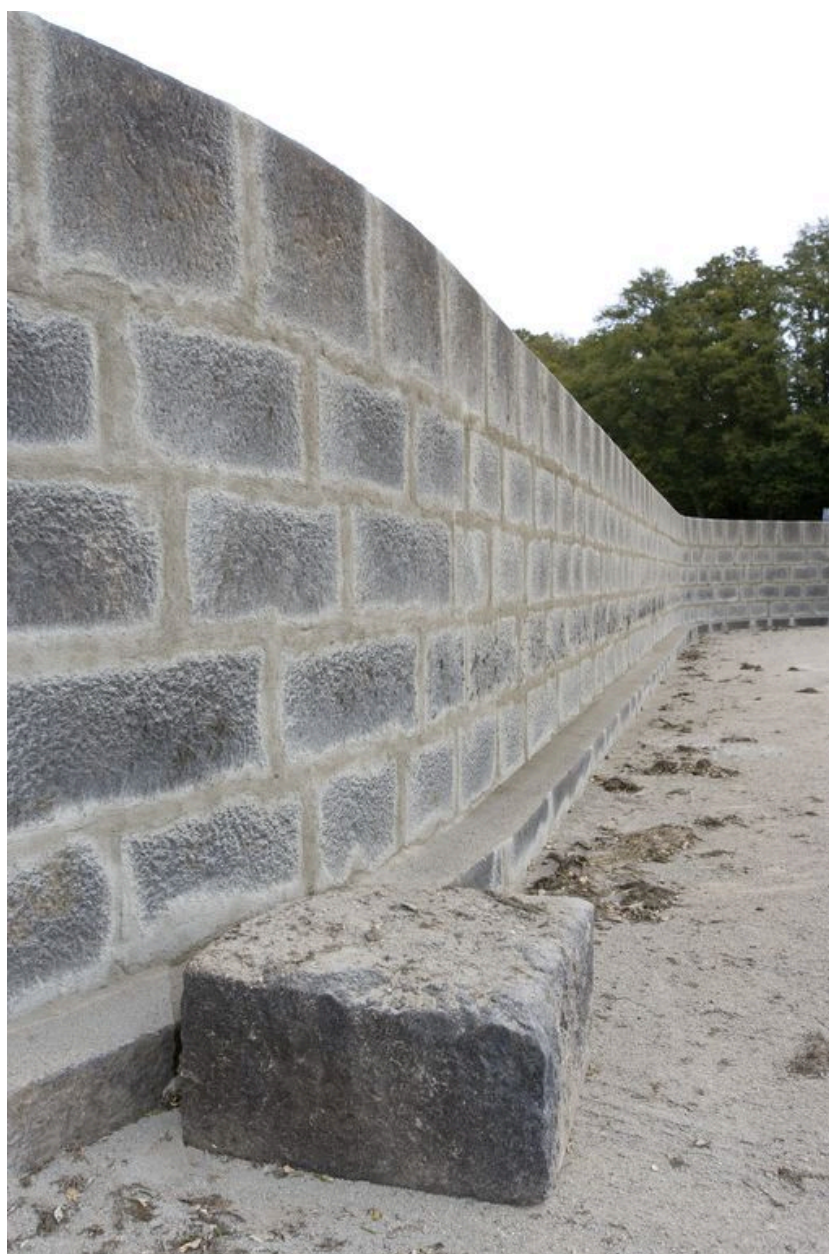
Détail de l'appareil de pierre de taille de granite du barrage, du côté aval, pendant les écourues de 2009.
