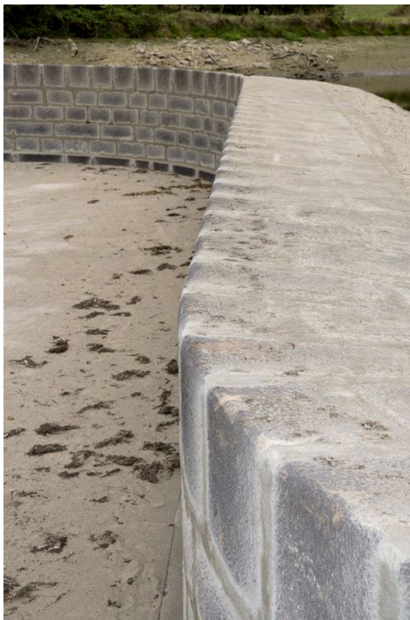
Détail du barrage vu depuis l'est pendant les écourues de 2009.
