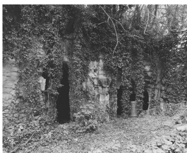
Entrées de caves, au nord (en 1996). Phot. Bruno Rousseau IVR52_19964901473X
