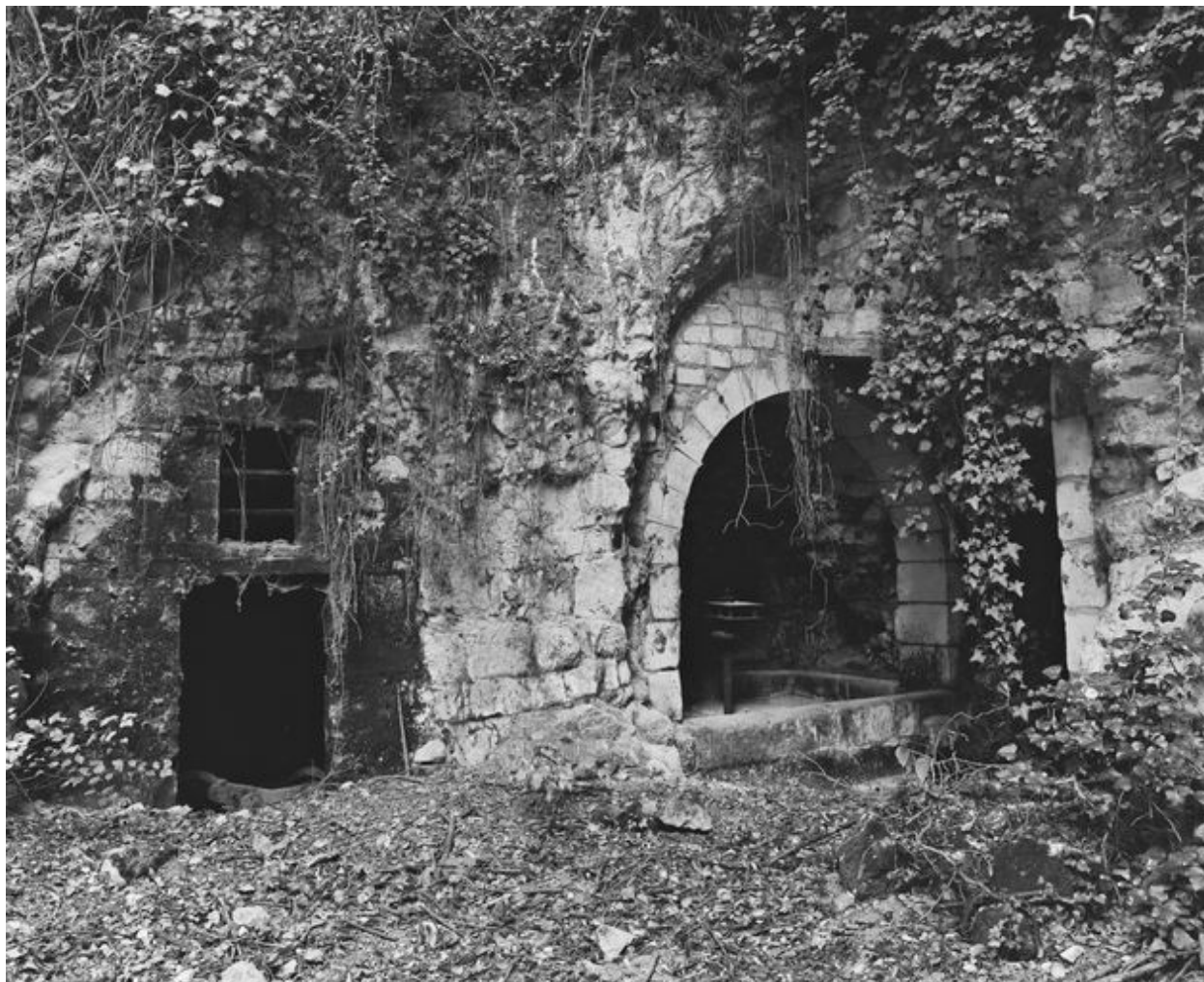
Entrée de caves, au sud, en 1996.
