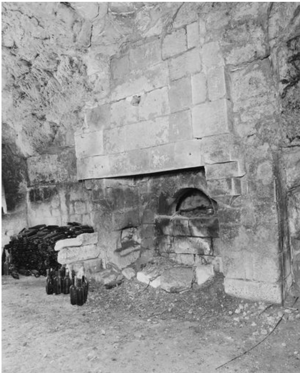
Cave principale, à l'ouest, cheminée du XVe ou XVIe siècle (remaniée), contre la paroi sud, en 1996.
