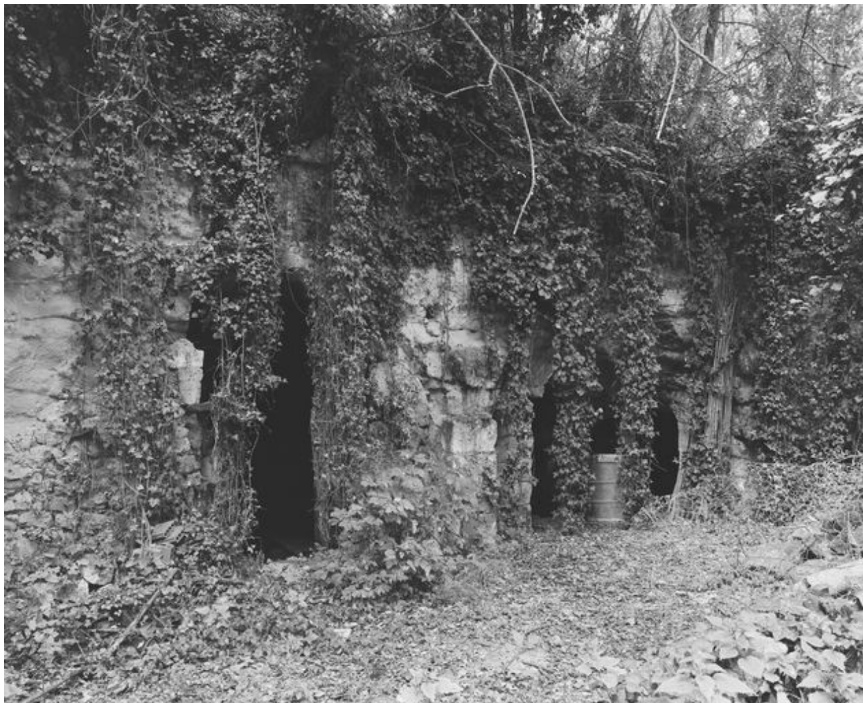
Entrées de caves, au nord (en 1996).
