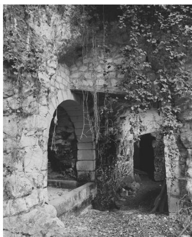
Entrée de caves, au sud-est, avec pressoir à gauche, en 1996. Phot. Bruno Rousseau IVR52_19964901476X
