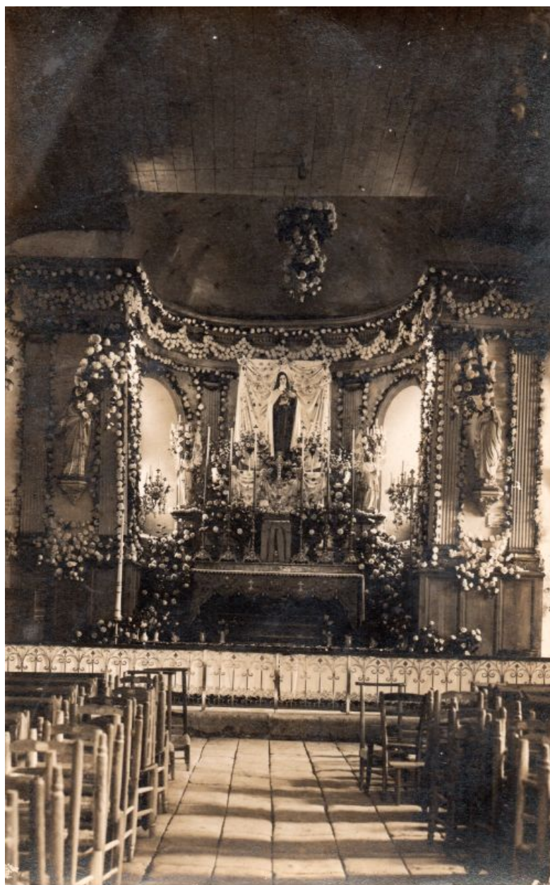
Vue du choeur en 1927 sur laquelle on aperçoit le semis d'étoiles sur la voûte.
