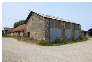
Vue d'ensemble des granges-étables depuis l'est. Phot. Armelle Maugin IVR52_20254900669NUCA
