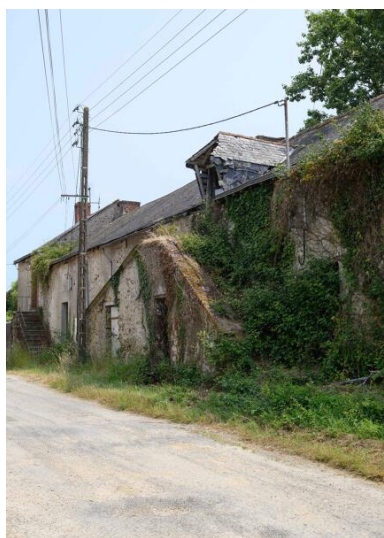
Façade nord des logis de la ferme du Theil. Phot. Armelle Maugin IVR52_20254900672NUCA
