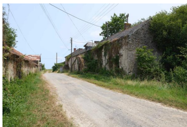
Vue d'ensemble des logis de la ferme du Theil depuis l'ouest. Phot. Armelle Maugin IVR52_20254900671NUCA
