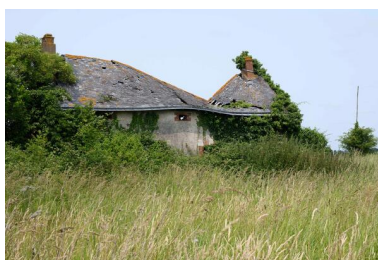
Vue depuis le sud du logis du XIXe siècle à l'est. Phot. Armelle Maugin IVR52_20254900676NUCA
