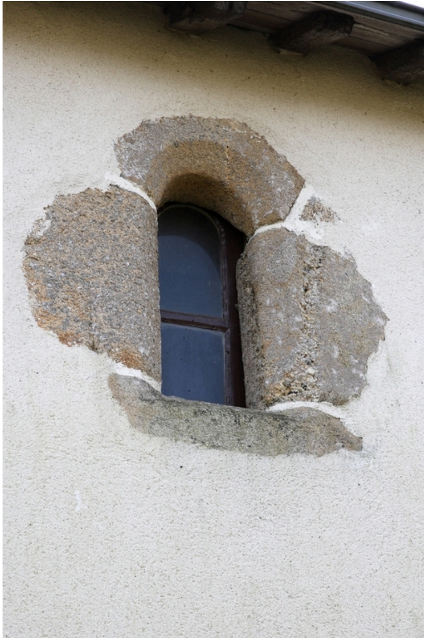
Détail du jour du 1er étage du 3e logis (3 rue de la Croix).
