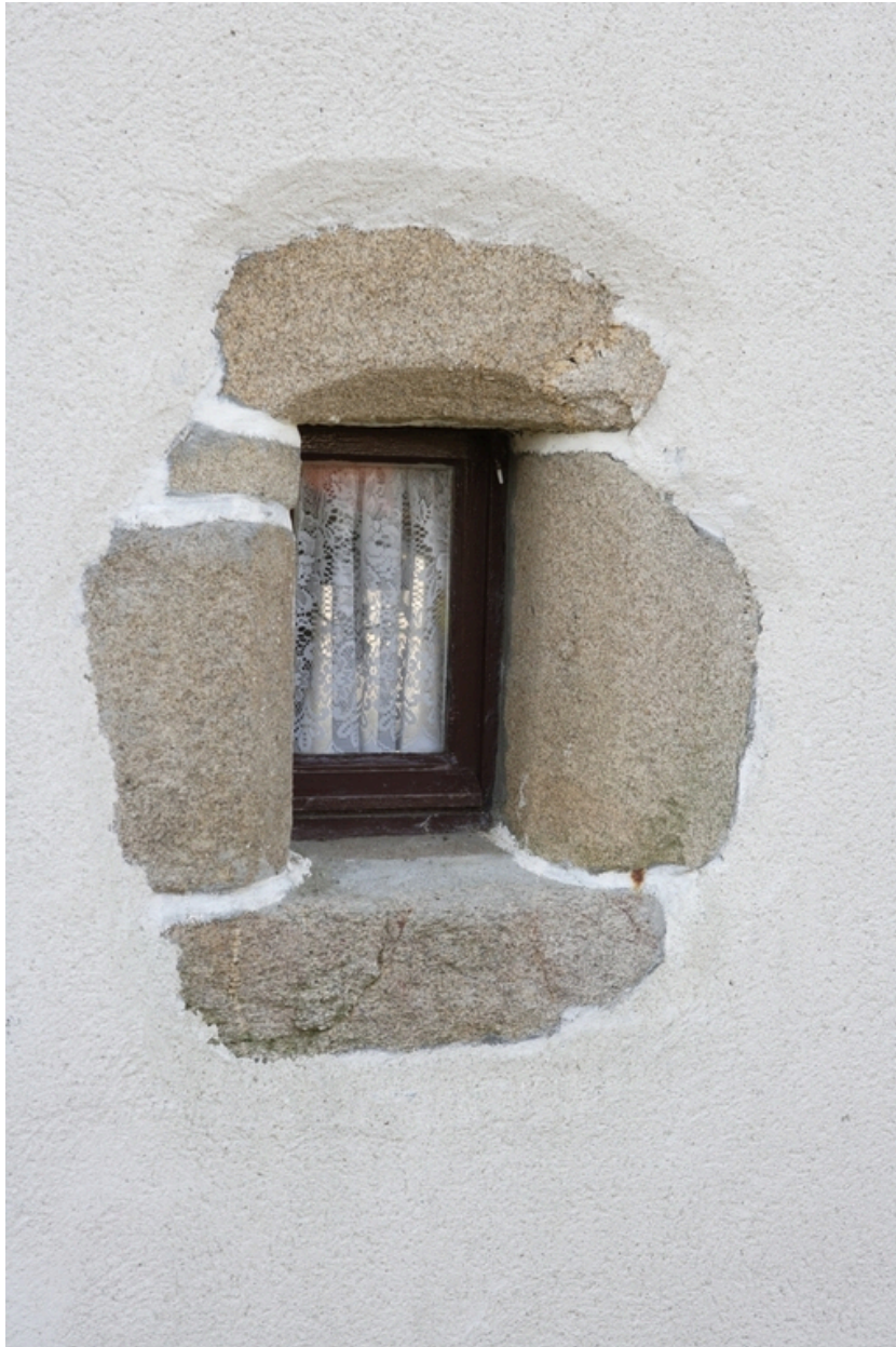
Détail du jour du rez-de-chaussée du 2e logis (2 rue de la Croix).
