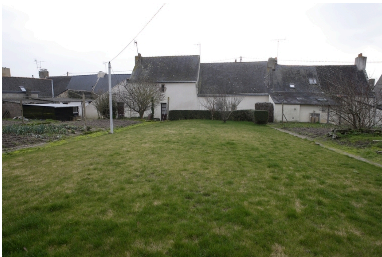
Vue de la rangée depuis le nord.
