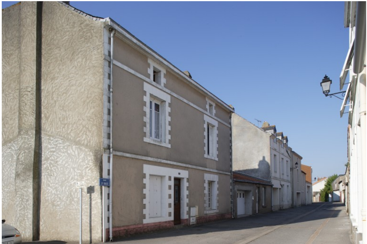
La rue Saint-Gilles : au premier plan la maison n° 5.
