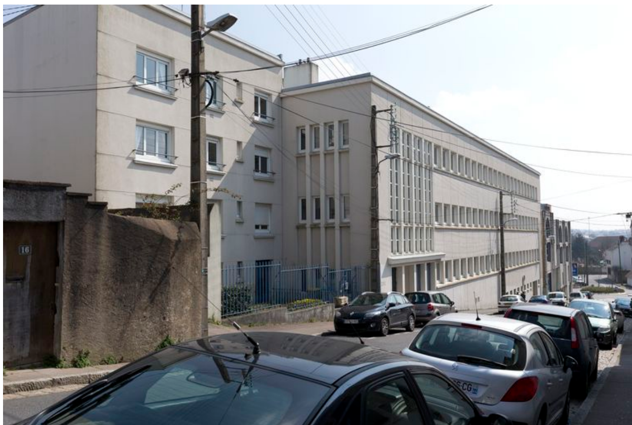
Bâtiment des années 1950.
