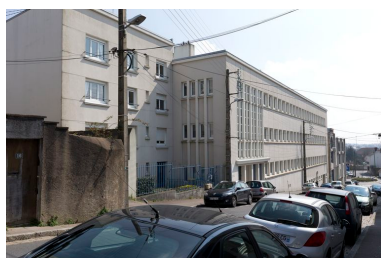
Bâtiment des années 1950. Phot. Denis Pillet IVR52_20134401420NUCA
