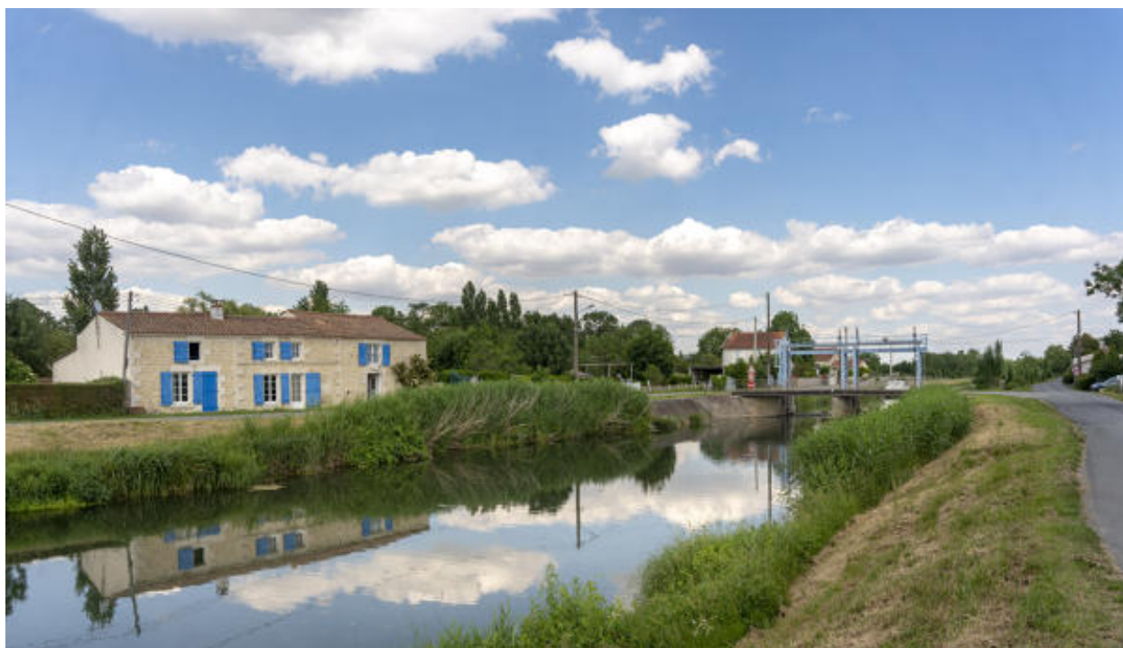
L'embouchure et le barrage du Nouveau Béjou vus depuis l'aval, en direction de l'est.
