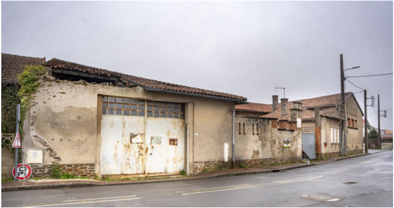
Vue d'ensemble depuis la rue Torbiche.
