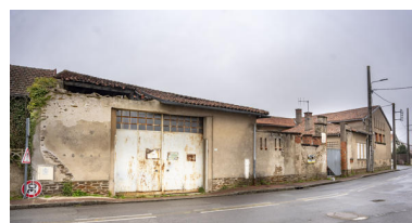
Vue d'ensemble depuis la rue Torbiche. Phot. Pierre-Bernard Fourny IVR52_20224400051NUCA
