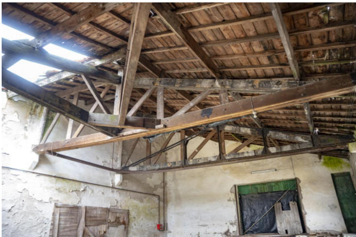
Salle dédiée au lavage des bouteilles, détail de la charpente en partie effondrée.
