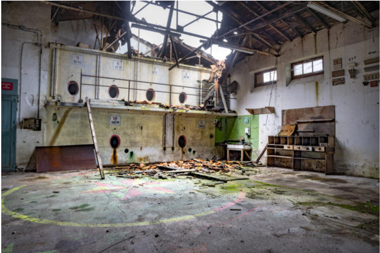
Cuverie principale, vue des superpositions de caves en partie ouest.
