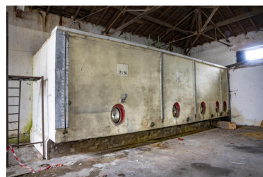
Cuverie principale, vue des cuves en partie nord. Phot. Pierre-Bernard Fourny IVR52_20224400054NUCA
