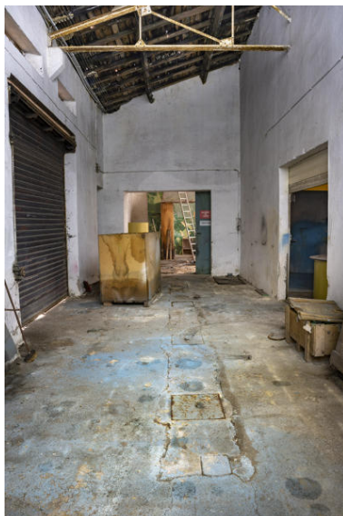
Quais de réception et cuves enterrées. Les salles attenantes abritaient le nécessaire pour la filtration et la mise en bouteille des vins. Phot. Pierre-Bernard Fourny IVR52_20224400052NUCA
