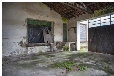
Zone de lavage des bouteilles, quai, et emplacement de la pompe, sous les escaliers. Au premier plan, trappe donnant accès au puits. Phot. Pierre-Bernard Fourny IVR52_20224400059NUCA
