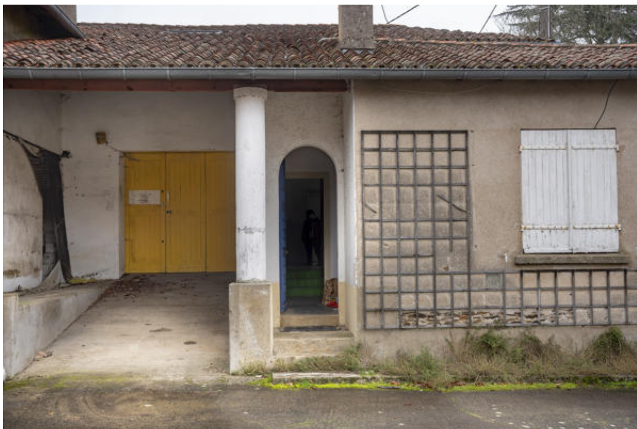
Vue de la rampe et de l'accès aux bureaux, depuis la cour intérieure.
