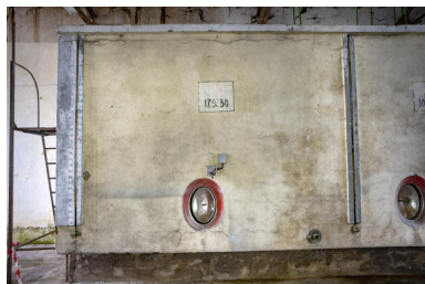
Détail d'une cuve aérienne, cuverie principale. Phot. Pierre-Bernard Fourny IVR52_20224400053NUCA
