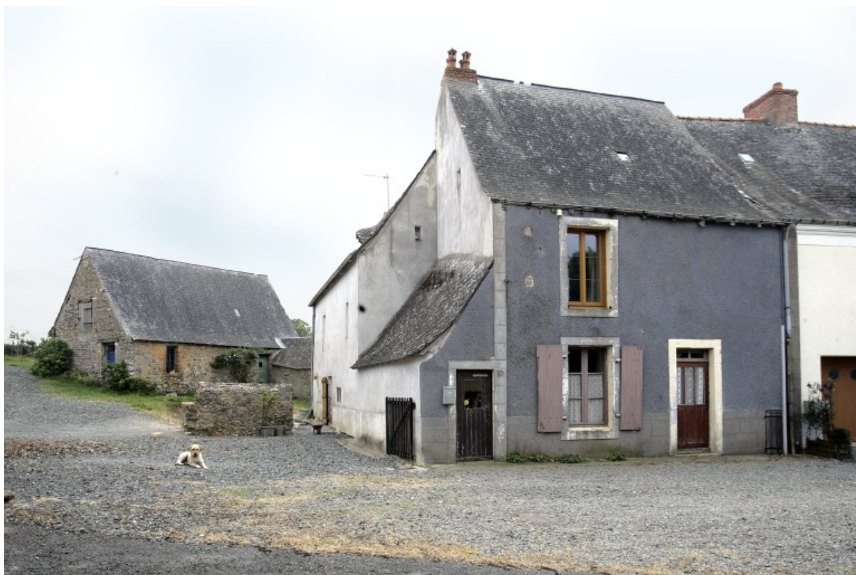
La maison et sa dépendance vues depuis le nord-est.
