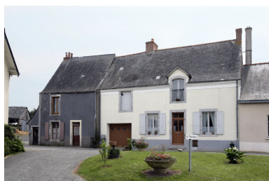
Vue depuis le nord. La maison est à gauche. Phot. François Lasa IVR52_20075302206NUCA
