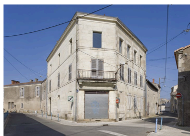
Vue de volume prise du sud-ouest. Au premier plan, le 1 rue des Gentilshommes,
