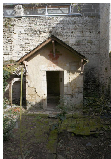
Toilettes au fond du jardin. Phot. Patrice Giraud IVR52_20098500179NUCA
