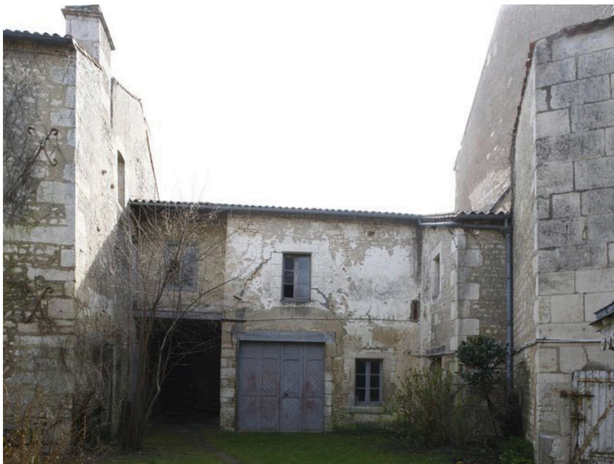
Vue prise du nord, montrant la façade sur cour du bâtiment d'entrée : écurie, grenier à foin et logement du palefrenier.
