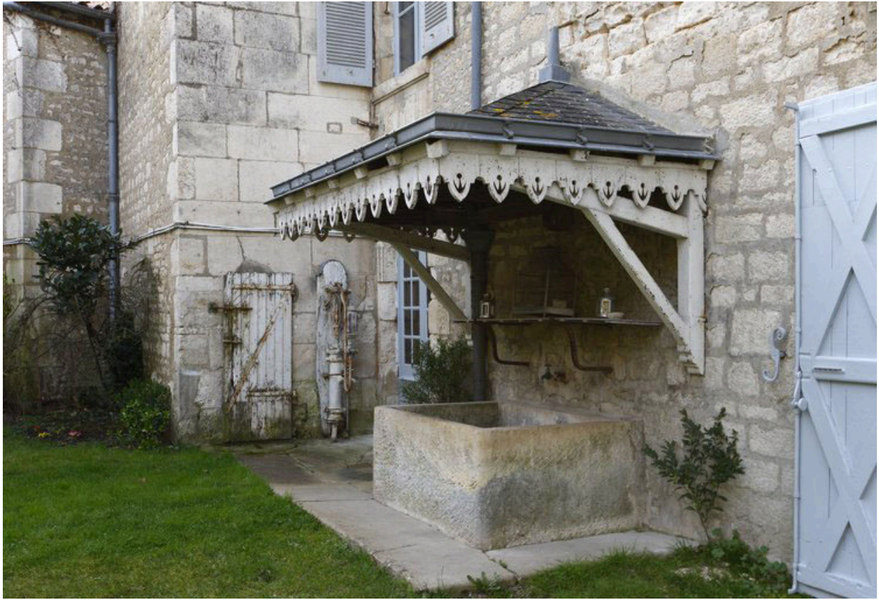
Vue du lavoir.
