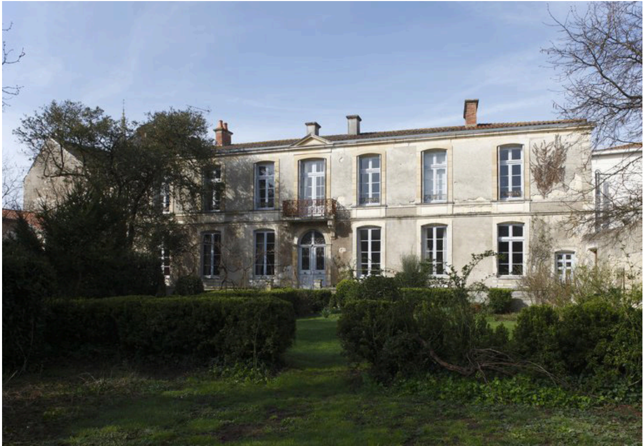
Façade est, donnant sur la terrasse et le jardin.
