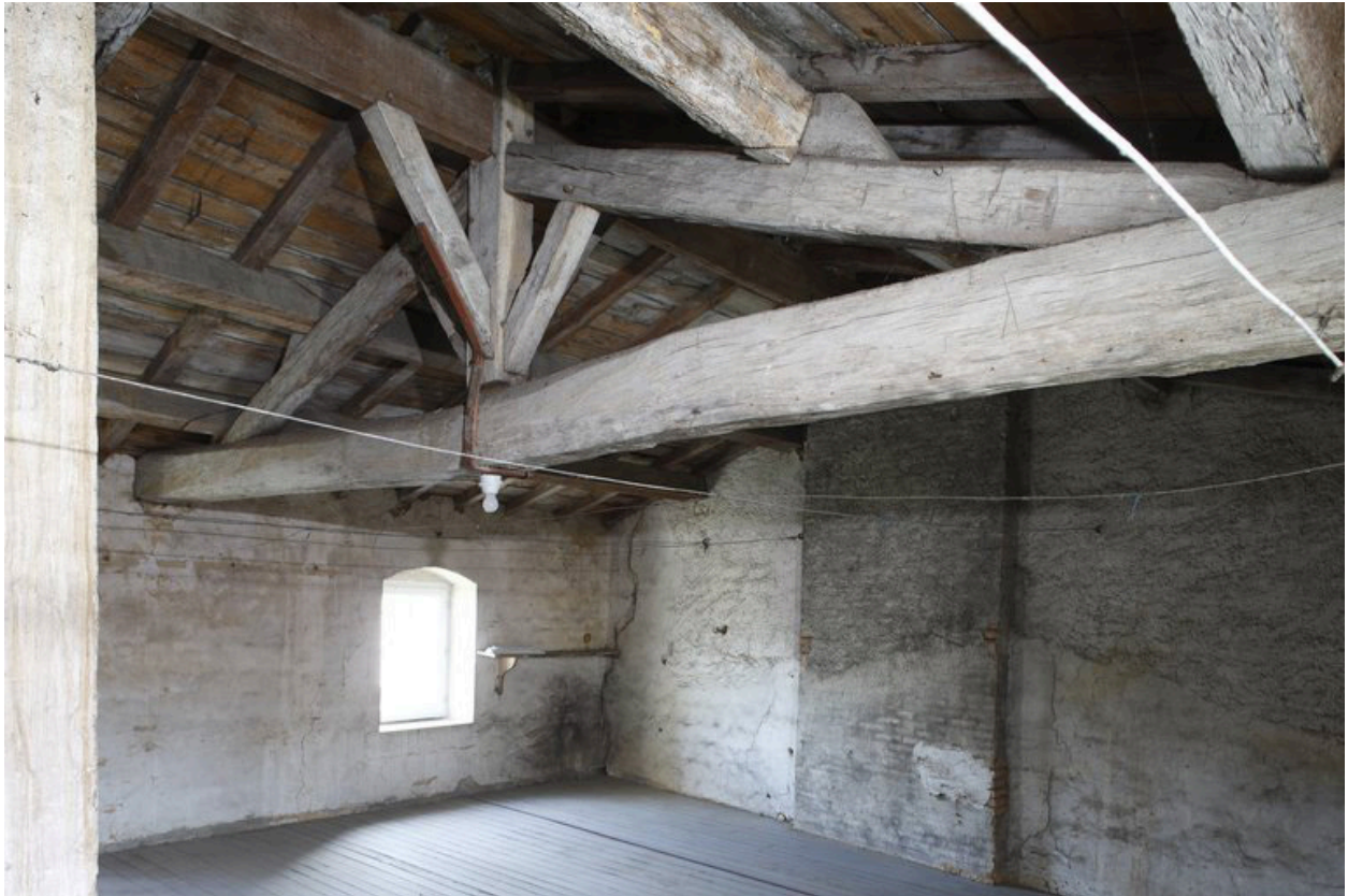
Partie sud : vue de la charpente, rehaussée lors des travaux du XIXe siècle.
