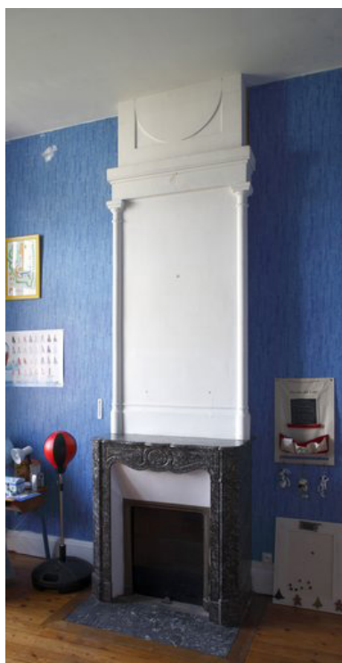
Partie nord : cheminée de l'une des chambres du premier étage. Phot. Patrice Giraud IVR52_20098500151NUCA
