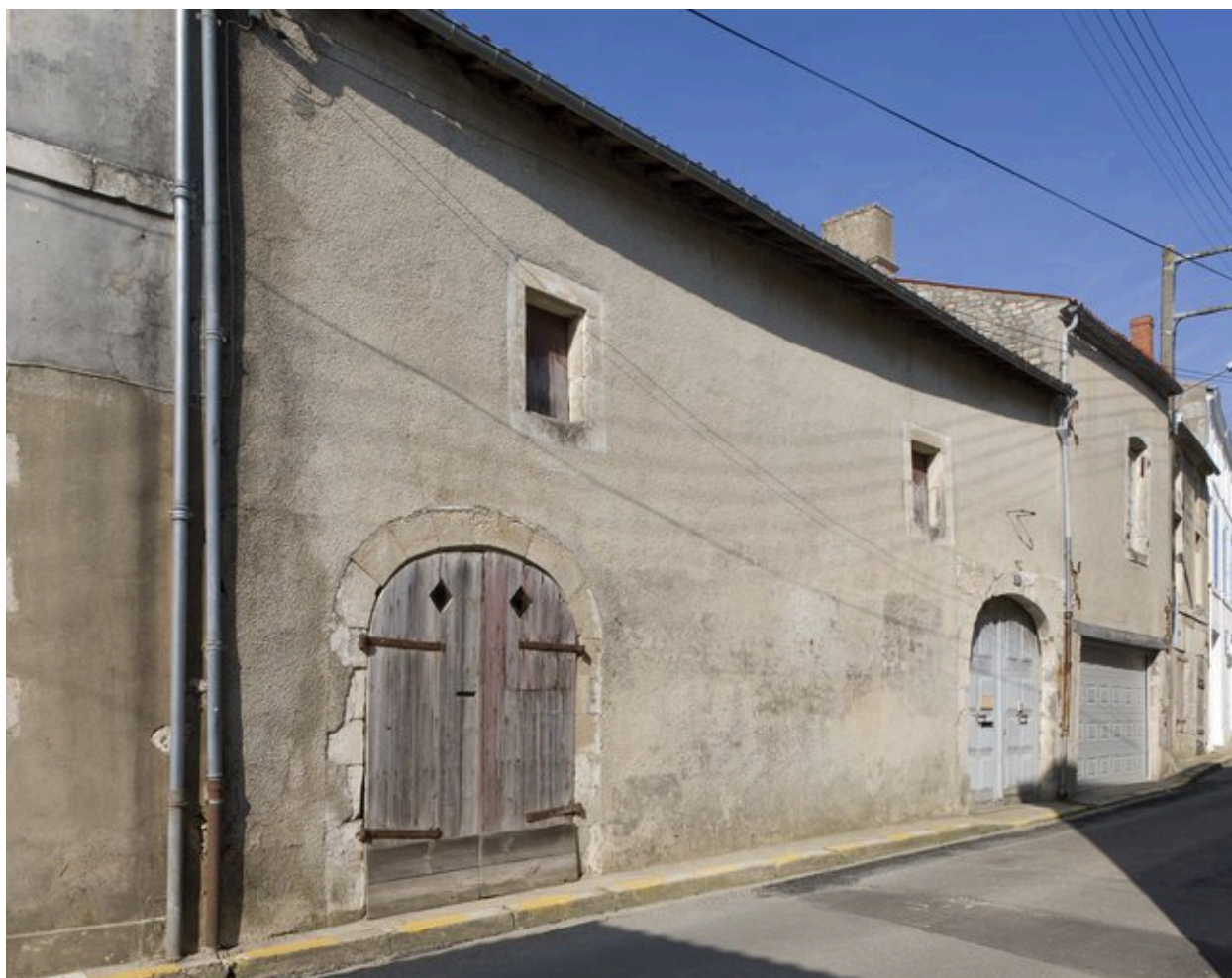
Façade du bâtiment d'entrée du 3, rue des Gentilshommes.
