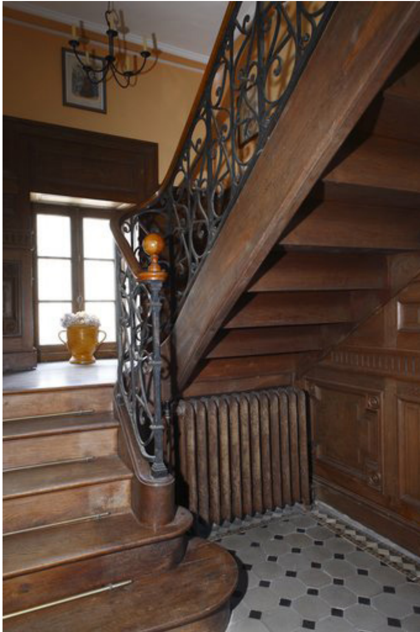
Partie nord : départ de l'escalier.
