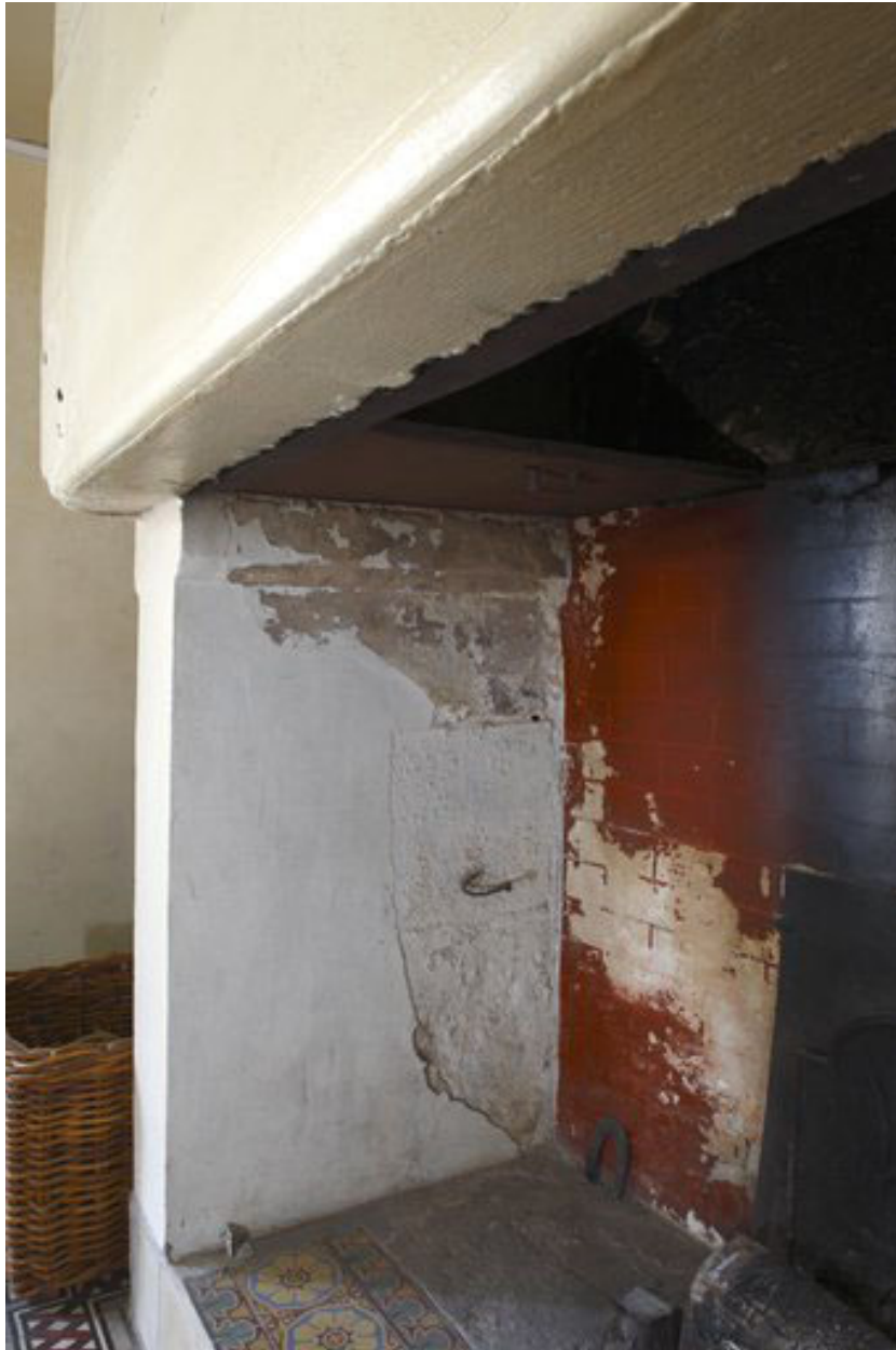
Partie sud : détail de la cheminée de la cuisine, montrant le profil d'origine (en console) des piédroits.
