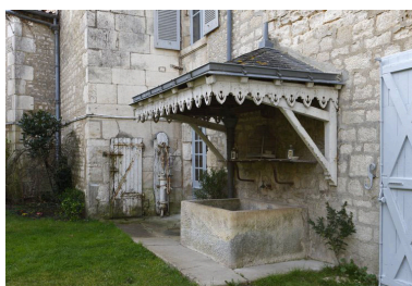
Vue du lavoir. Phot. Patrice Giraud IVR52_20098500176NUCA
