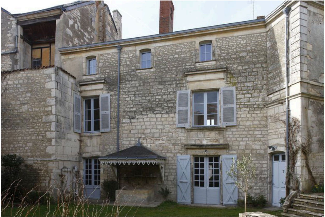
Vue prise de l'est, montrant la partie sud de la demeure (cuisine etc) et le lavoir.
