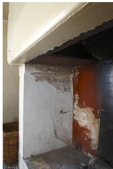
Partie sud : détail de la cheminée de la cuisine, montrant le profil d'origine (en console) des piédroits. Phot. Patrice Giraud IVR52_20098500171NUCA
