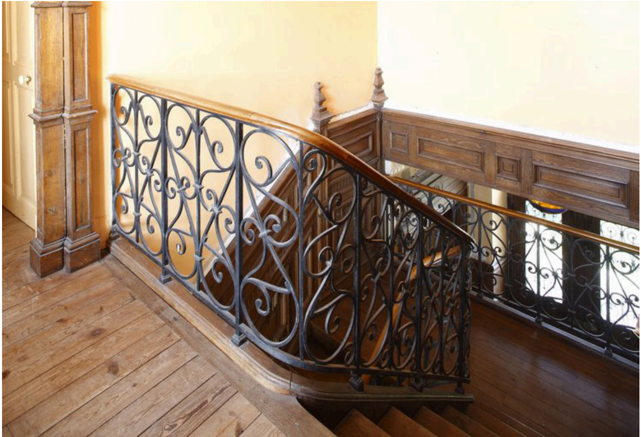
Partie nord : vue de l'escalier prise du couloir du premier étage, montrant la rampe en fer forgé.
