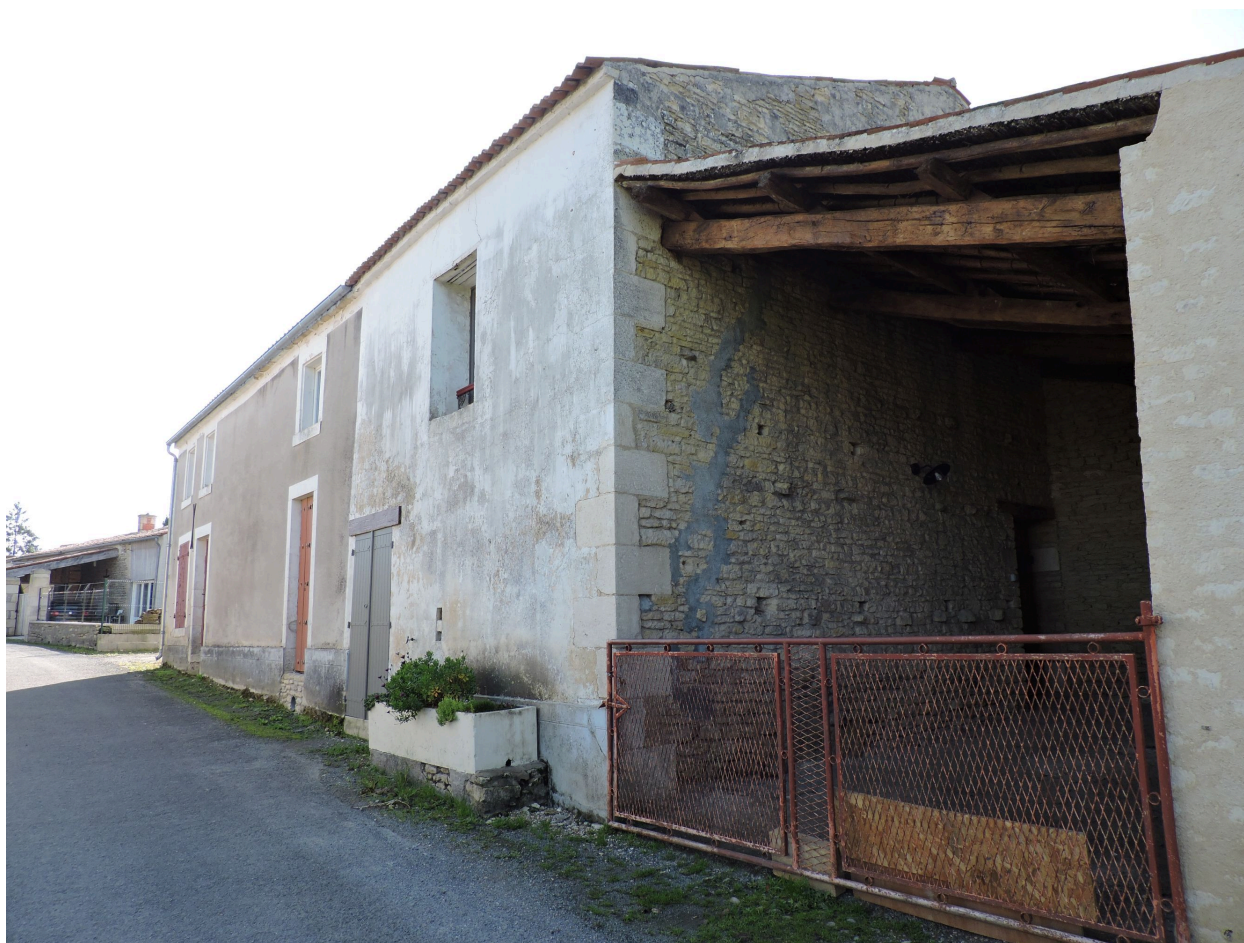
Les dépendances vues depuis le nord-ouest.
