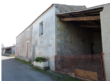
Les dépendances vues depuis le nord-ouest. Phot. Yannis Suire IVR52_20218500278NUCA
