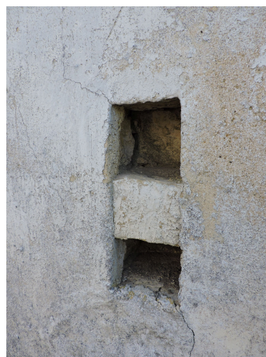
Anneau d'attache aménagé dans le mur de façade de la grange-étable. Phot. Yannis Suire IVR52_20218500279NUCA
