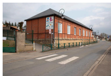
Le bâtiment des classes, côté rue. Phot. Pierre-Bernard Fourny IVR52_20197200687NUCA
