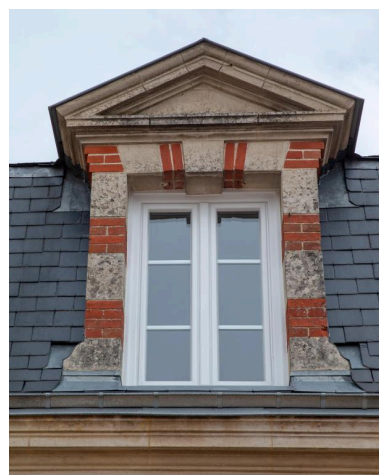
Un détail d'une lucarne du logement. Phot. Pierre-Bernard Fourny IVR52_20197200694NUCA
