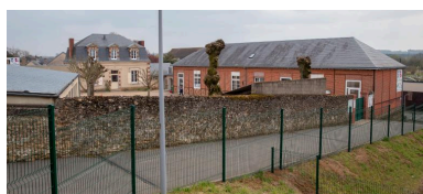
Une vue d'ensemble de l'école. Phot. Pierre-Bernard Fourny IVR52_20197200695NUCA
