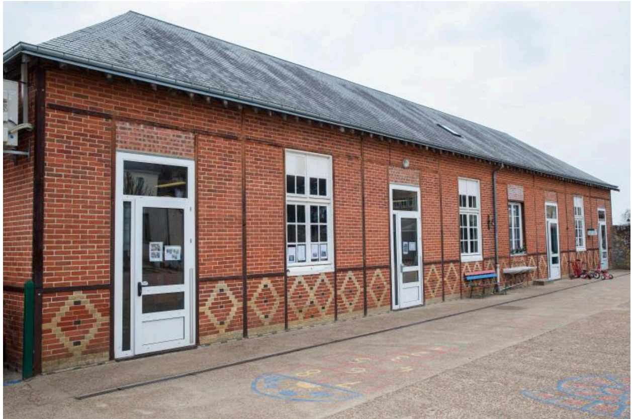
Le bâtiment des classes, côté cour.
