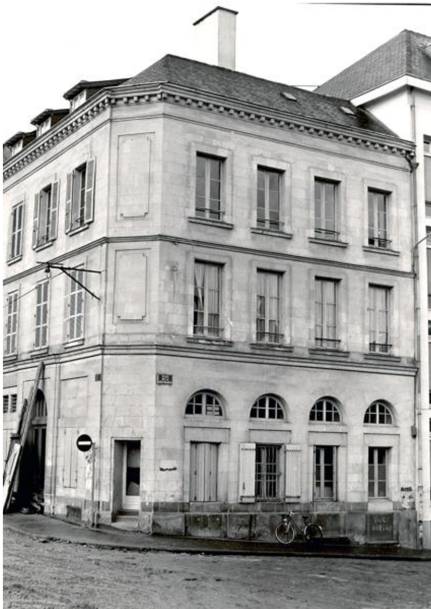
Façades à l'angle de la rue Millet et sur la place de la République.
