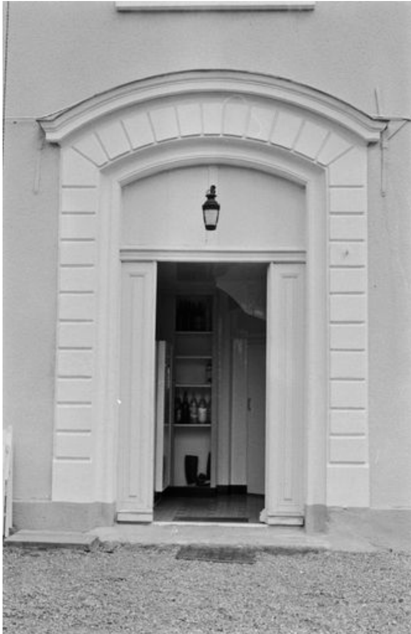
Détail de la porte d'entrée principale (façade donnant sur la Sarthe).
