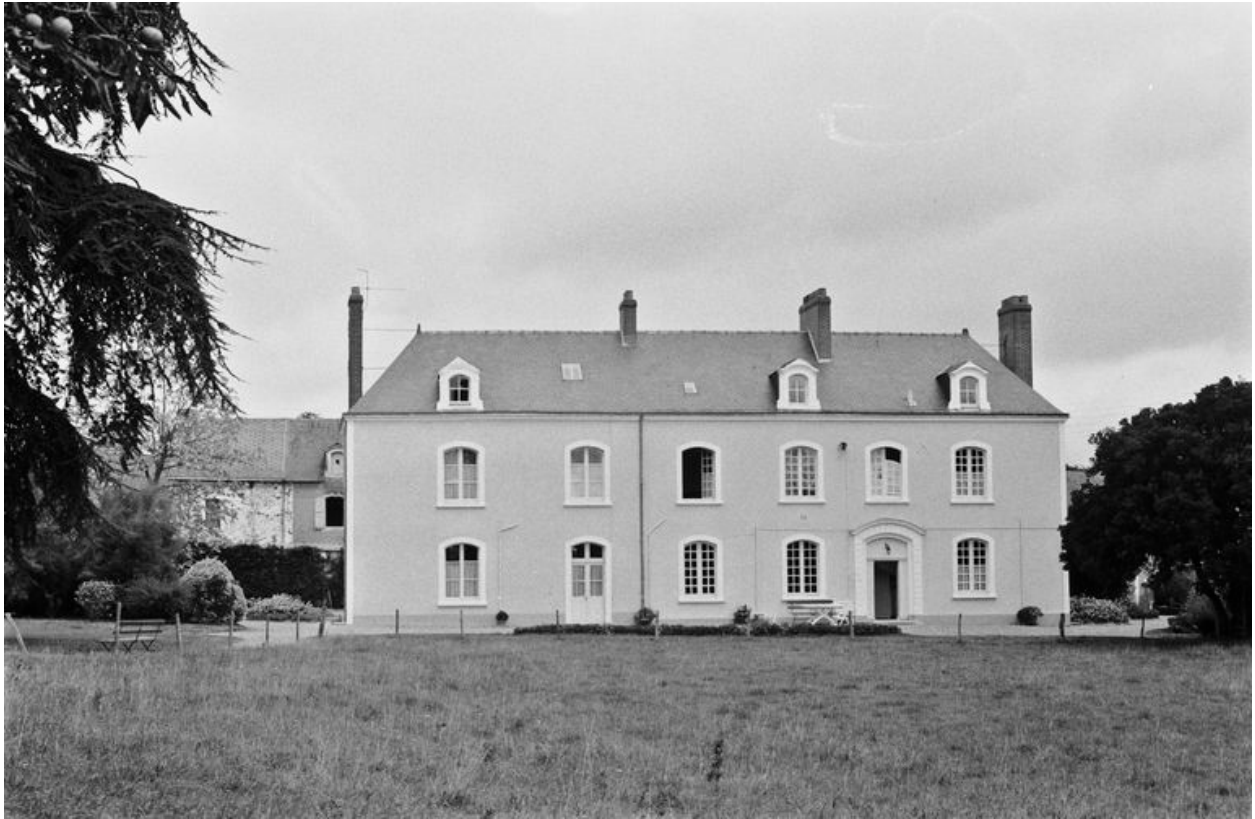
Façade donnant sur la Sarthe.
