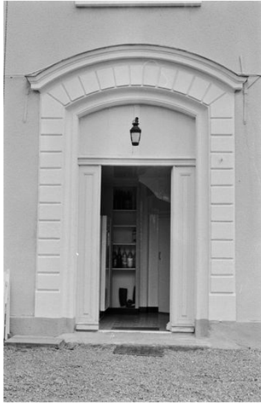
Détail de la porte d'entrée principale (façade donnant sur la Sarthe). Phot. Claire Labalte, Phot. Bruno Rousseau IVR52_19744900274Z
