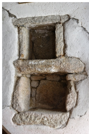
Détail du placard mural (4 rue de l'Aha). Phot. Denis Pillet IVR52_20074401379NUCA
