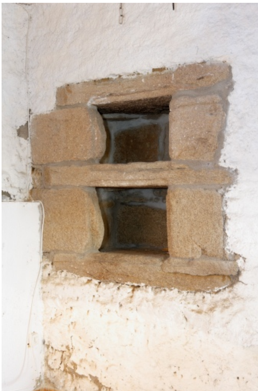
Détail de la niche murale (6 rue de l'Aha).
