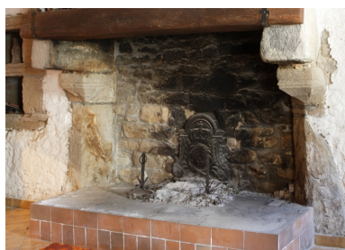
Vue de la cheminée (6 rue de l'Aha). Phot. Denis Pillet IVR52_20074401381NUCA
