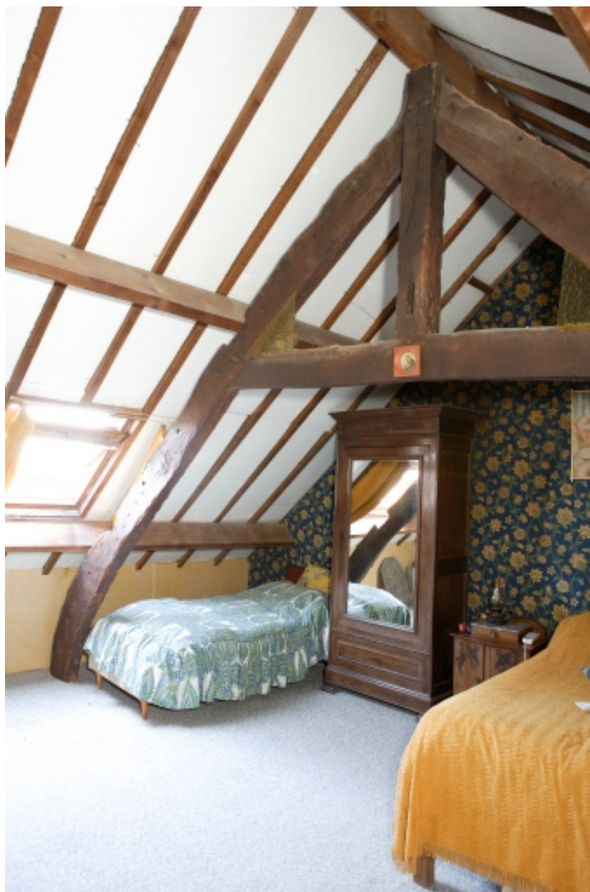
Vue de la charpente (6 rue de l'Aha).
