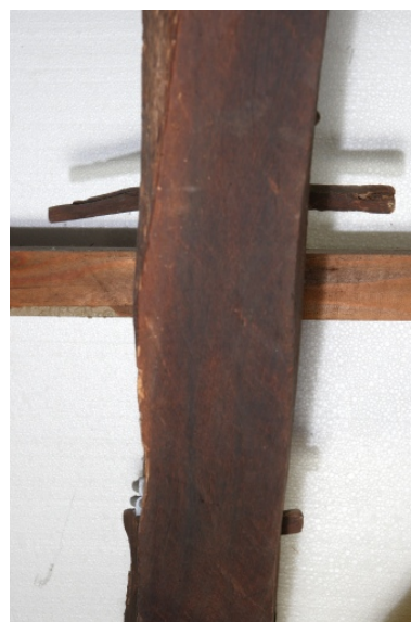
Détail d'une cheville permettant de créer un échelier sur le chevron- arbalétrier (6 rue de l'Aha). Phot. Denis Pillet IVR52_20074401386NUCA
