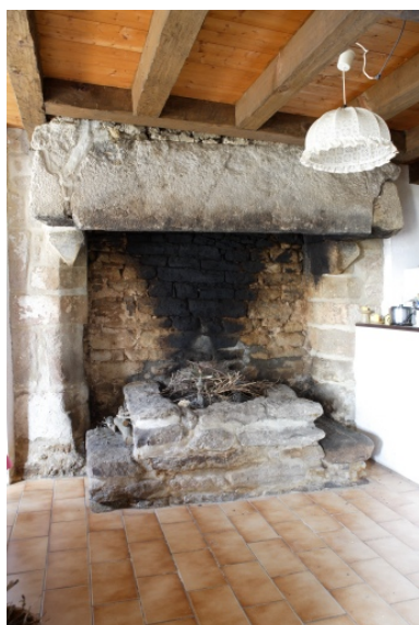
Vue de la cheminée (4 rue de l'Aha). Phot. Denis Pillet IVR52_20074401377NUCA
