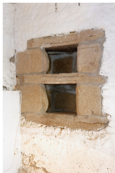
Détail de la niche murale (6 rue de l'Aha). Phot. Denis Pillet IVR52_20074401383NUCA
