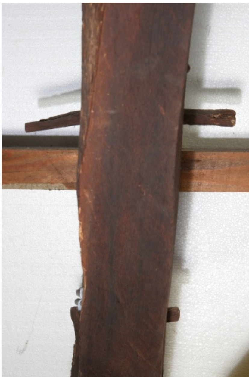
Détail d'une cheville permettant de créer un échelier sur le chevron-arbalétrier (6 rue de l'Aha).
