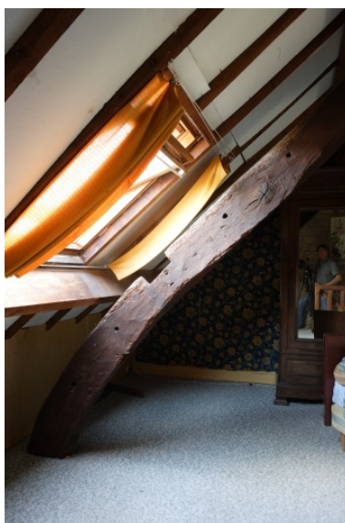
Détail d'un chevron-arbalétrier de la charpente (6 rue de l'Aha). Phot. Denis Pillet IVR52_20074401384NUCA
