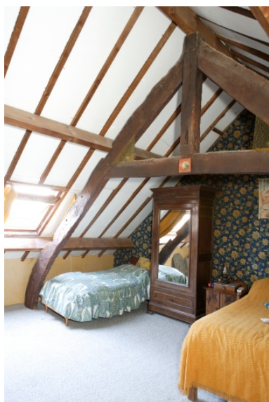
Vue de la charpente (6 rue de l'Aha). Phot. Denis Pillet IVR52_20074401385NUCA
