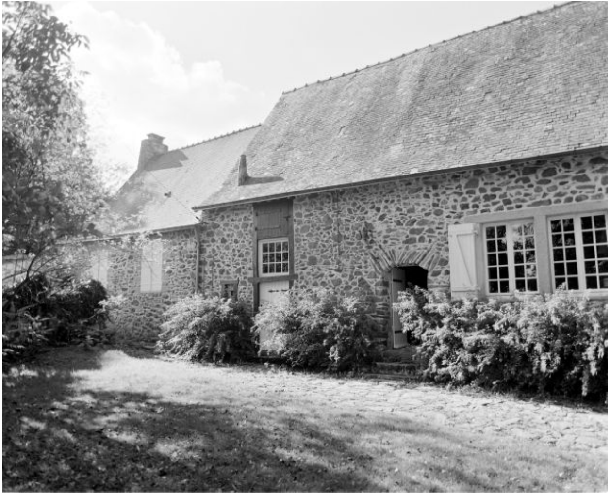
Façade sud des anciennes dépendances du moulin.
