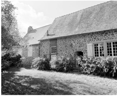
Façade sud des anciennes dépendances du moulin.
