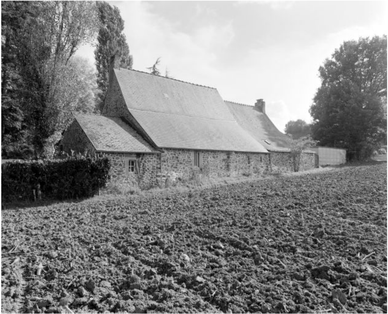
Façade nord des anciennes dépendances du moulin : en appentis, ancien cellier (?).
