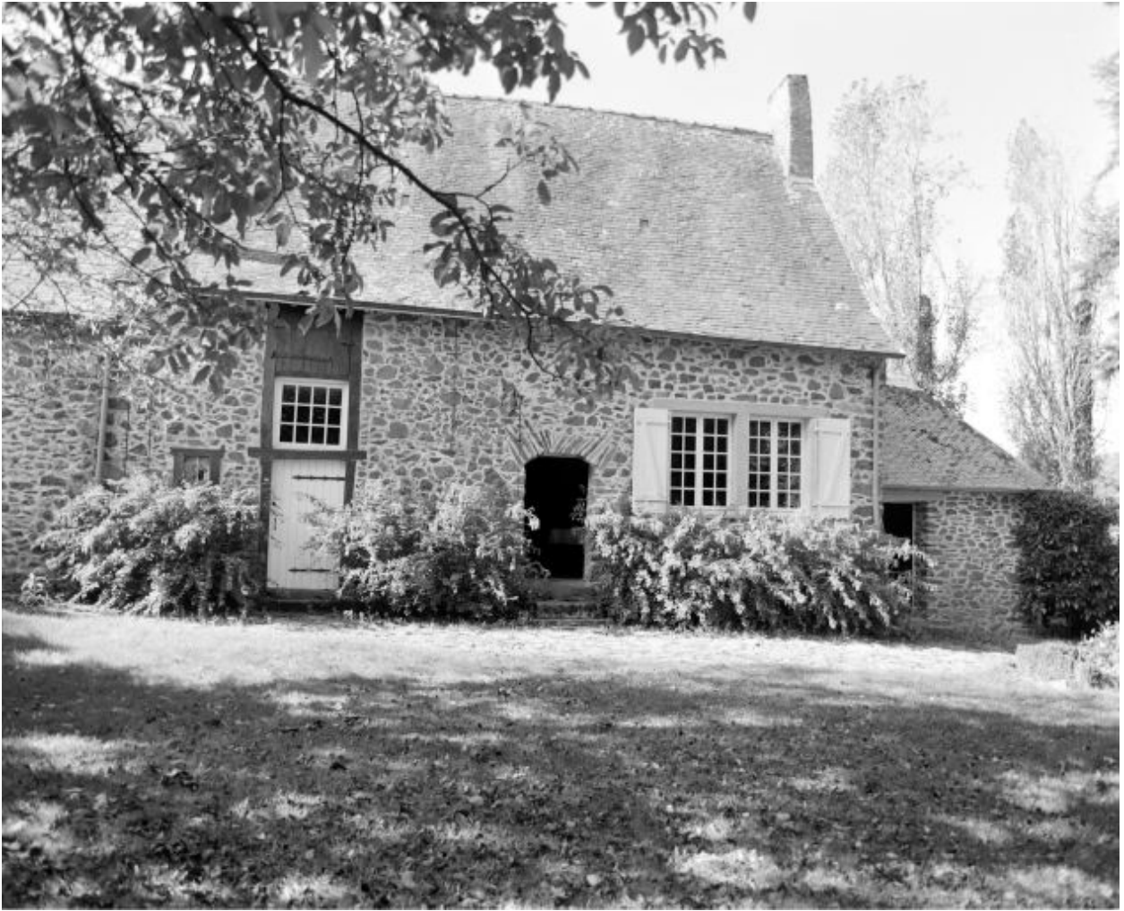
Façade sud des anciennes dépendances du moulin : à droite, le logis du meunier, à gauche, porte d'une ancienne étable (?), surmontée d'un accès au grenier.
