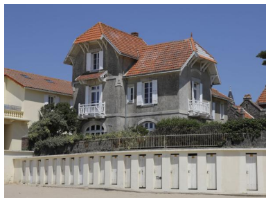
Vue d'ensemble depuis la plage. Phot. Denis Pillet IVR52_20124400338NUCA
