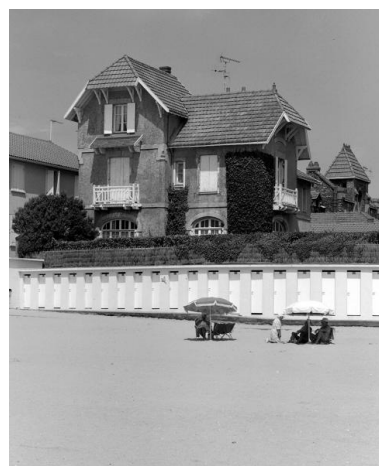
Élévation sud-ouest. Phot. Denis Pillet IVR52_19974402360X
