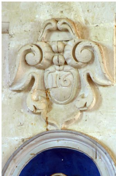
Détail : cuir avec la date, côté nord. Phot. Jean-Baptiste Darrasse IVR52_20087201132NUCA
