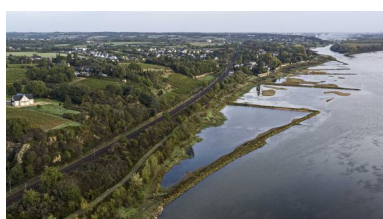
La confluence et la voie de chemin de fer longeant le coteau de la rive droite. Phot. Yves Guillotin IVR52_20194901001NUCA
