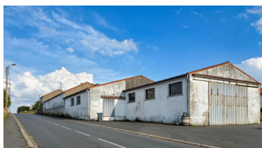
Vue générale depuis l'ouest. IVR52_20234400370NUCA
