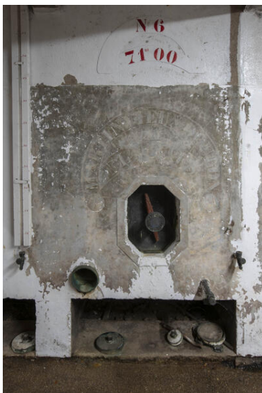
Cuve aérienne. Phot. Pierre-Bernard Fourny IVR52_20224400355NUCA
