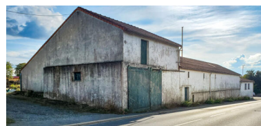
Vue générale depuis l'est. IVR52_20234400371NUCA
