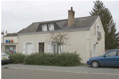
Vue depuis la route. Phot. François Lasa IVR52_20045303328NUCA
