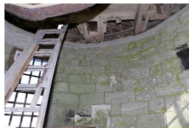
Intérieur de la cage. Détail d'une partie de la civière. Phot. Denis Pillet IVR52_20074401525NUCA
