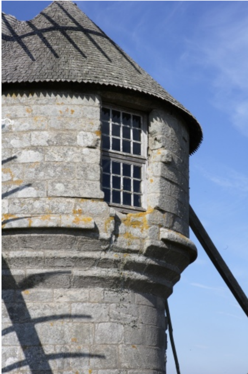
Cage. Détail de la porte haute sud-ouest.
