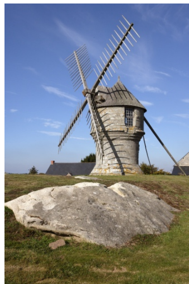
Vue d'ensemble depuis le sud-ouest. Phot. Denis Pillet IVR52_20074401515NUCA
