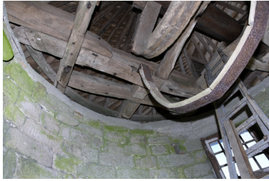
Vue intérieure de la coiffe ; l'arbre moteur, le rouet et la bande du frein. Phot. Denis Pillet IVR52_20074401526NUCA
