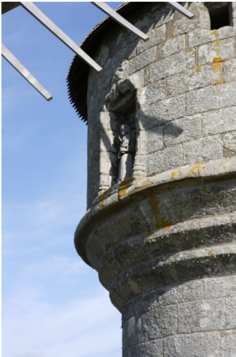
Cage, côté ouest. Détail de la niche et des mouluration de l'encorbellement de la cage.
