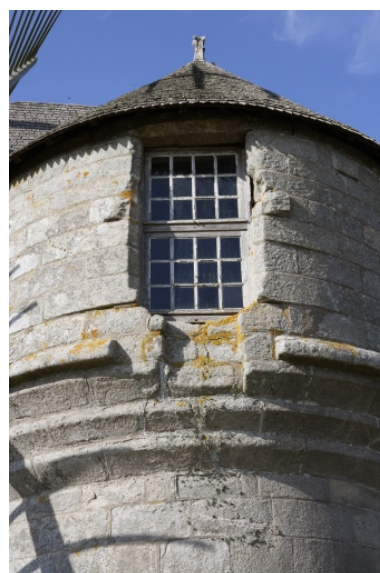
Cage, partie ouest. Détail de la porte-haute. Phot. Denis Pillet IVR52_20074401531NUCA
