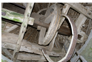
Vue intérieure de la coiffe ; l'arbre moteur, le rouet et la bande du frein. Phot. Denis Pillet IVR52_20074401524NUCA
