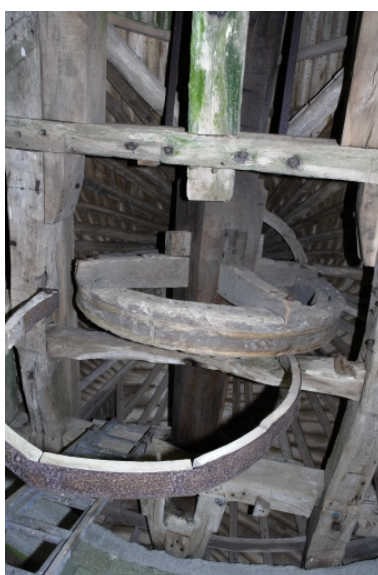
Vue intérieure de la coiffe ; l'arbre moteur, le rouet et la bande du frein. Phot. Denis Pillet
