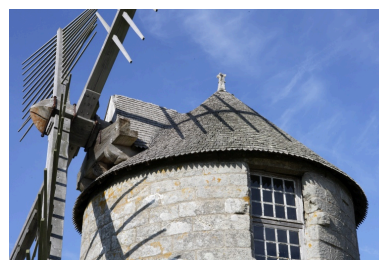
Coiffe, arbre et ailes. Phot. Denis Pillet IVR52_20074401518NUCA
