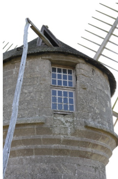
Cage, côté est. Détail de l'une des deux portes-hautes, et de la perche du frein. Phot. Denis Pillet IVR52_20074401521NUCA
