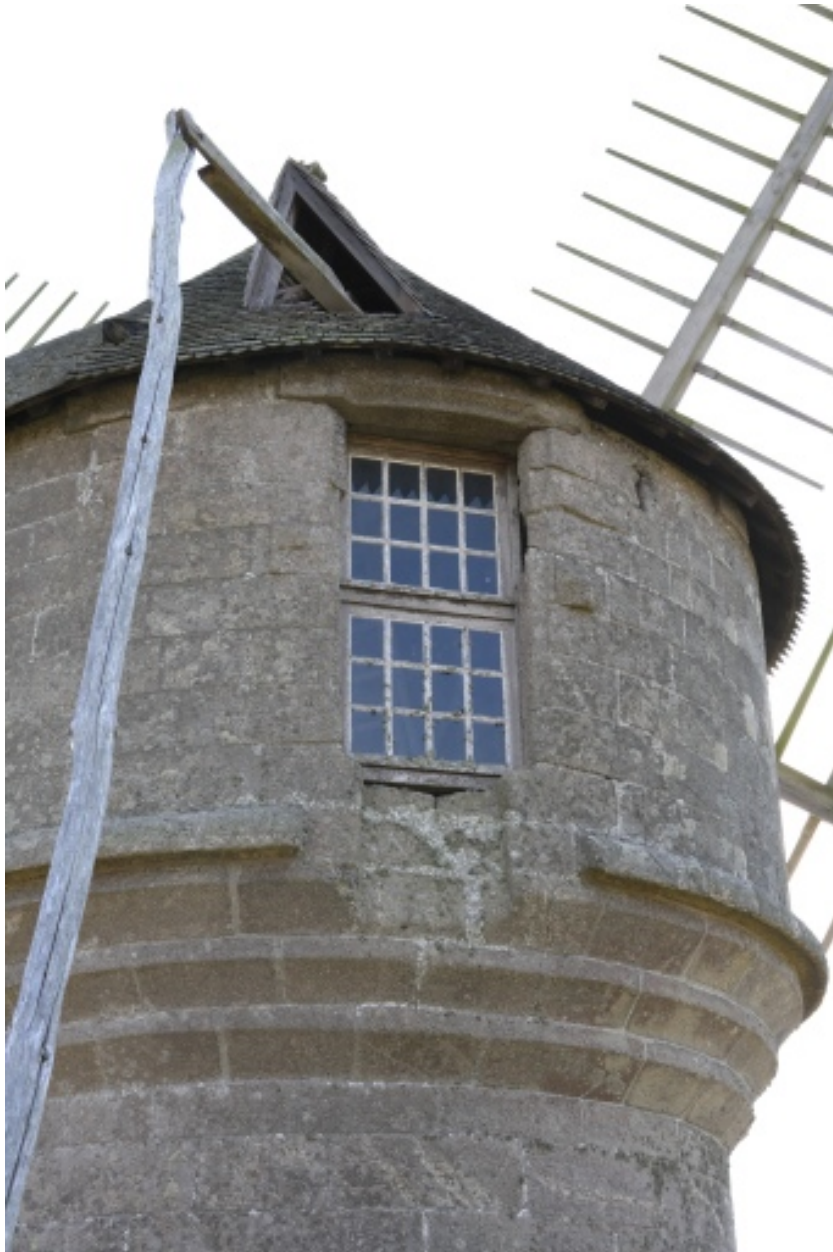
Cage, côté est. Détail de l'une des deux portes-hautes, et de la perche du frein.
