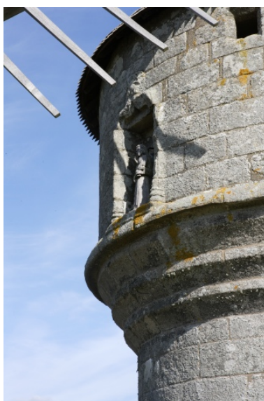
Cage, côté ouest. Détail de la niche et des mouluration de l'encorbellement de la cage. Phot. Denis Pillet IVR52_20074401519NUCA
