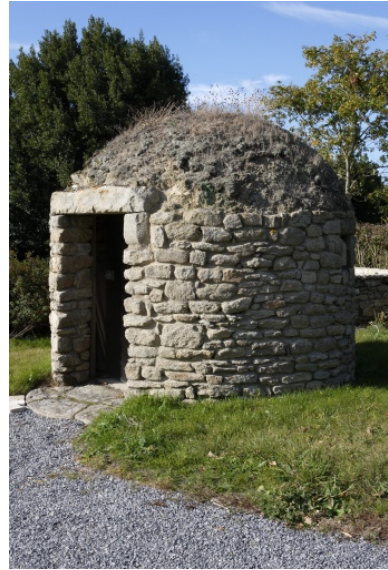
Toit à porcs. Phot. Denis Pillet IVR52_20074401533NUCA
