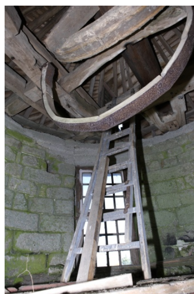
Vue intérieure de la coiffe ; la bande du frein. Phot. Denis Pillet
