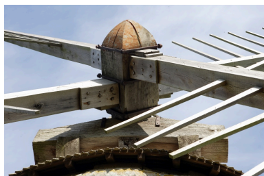
Détail de la tête de l'arbre, des verges et des verrons. Phot. Denis Pillet IVR52_20074401535NUCA
