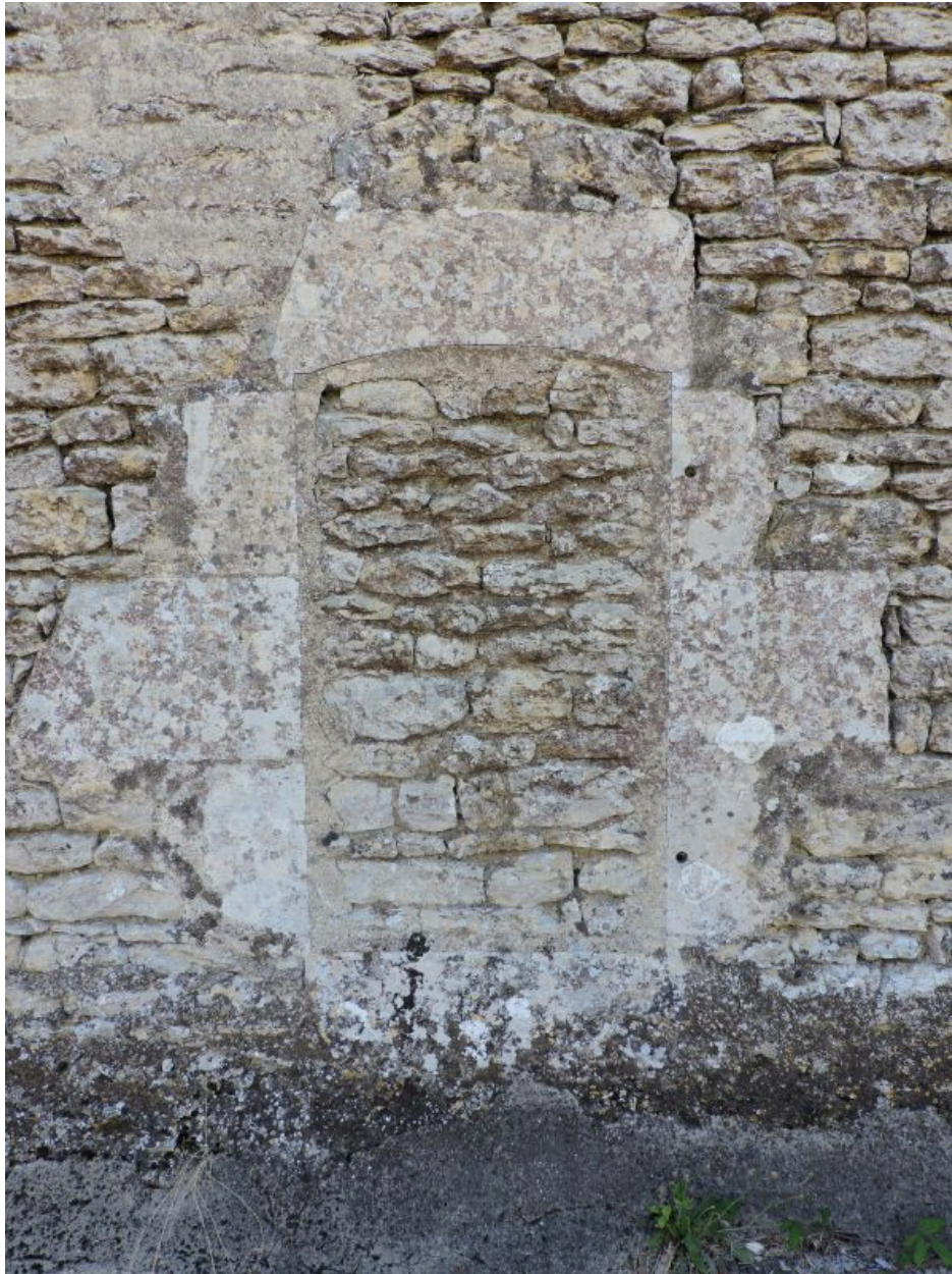
Ancienne baie murée, peut-être du 18e siècle, sur le côté nord du logis.
