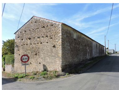
L'ancienne ferme vue depuis le nord. Phot. Yannis Suire IVR52_20198503208NUCA
