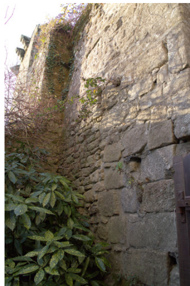
Détail du côté est, intra muros. Phot. Denis Pillet IVR52_20054402228NUCA
