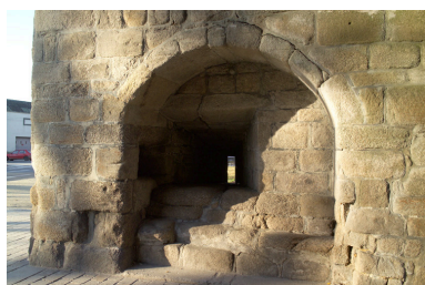
Ouverture de tir sous le passage. Phot. Denis Pillet IVR52_20054402224NUCA
