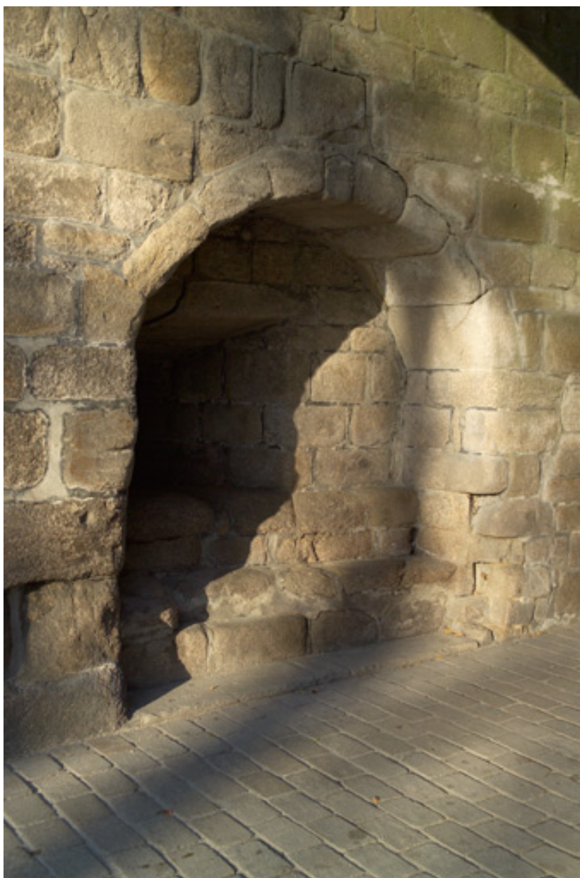
Ouverture de tir sous le passage.
