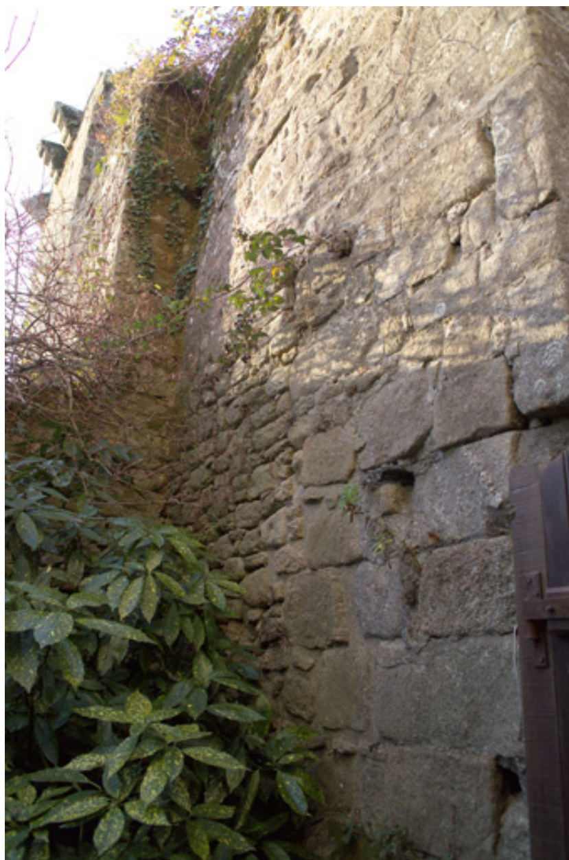
Détail du côté est, intra muros.
