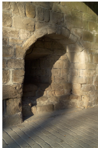
Ouverture de tir sous le passage. Phot. Denis Pillet IVR52_20054402223NUCA
