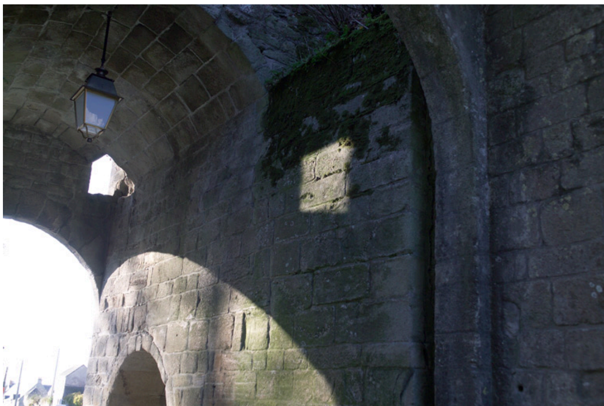
Détail de la voûte sous le passage.
