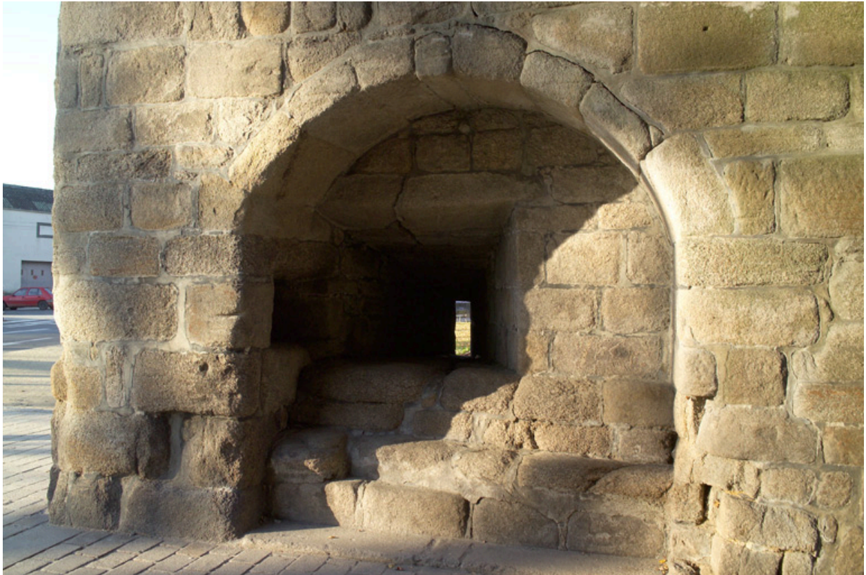
Ouverture de tir sous le passage.
