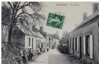
Les maisons (à gauche), carte postale oblitérée en 1912 (collection particulière). Phot. Pierre-Bernard Fourny IVR52_20197201544NUCA
