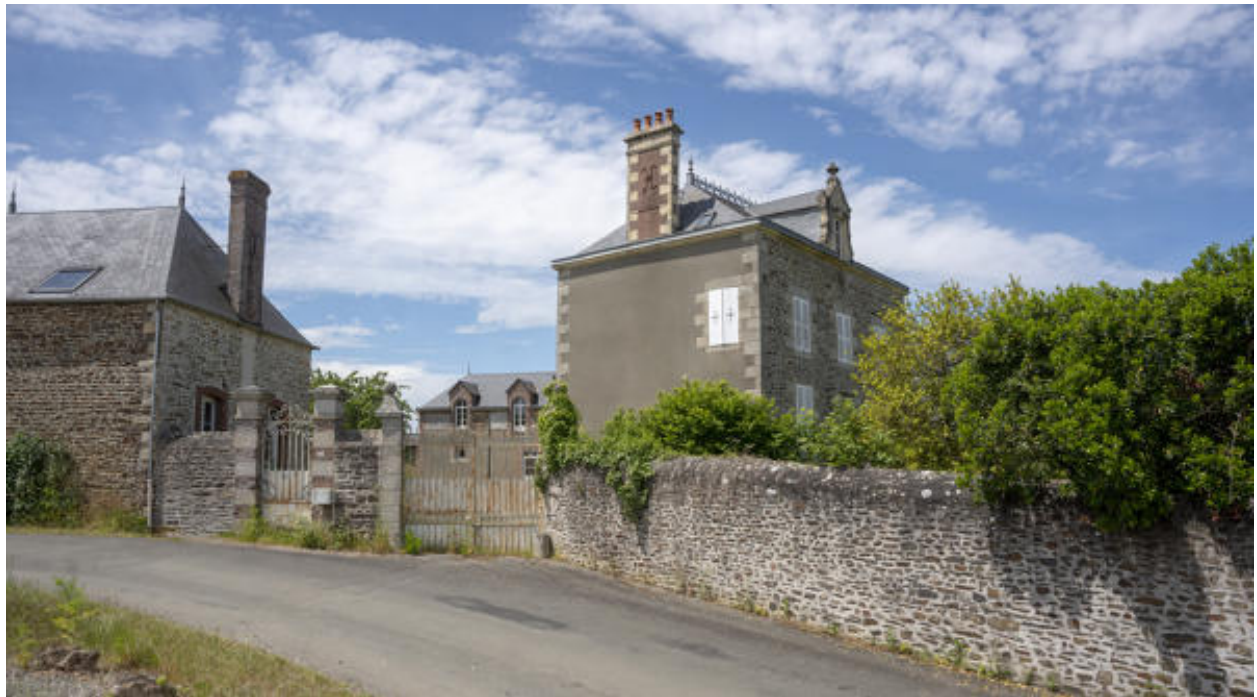
La maison et les communs à l'arrière.
