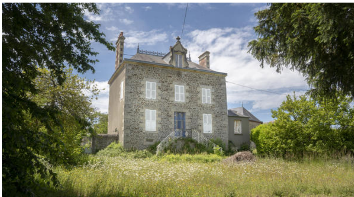
La façade antérieure de la maison.
