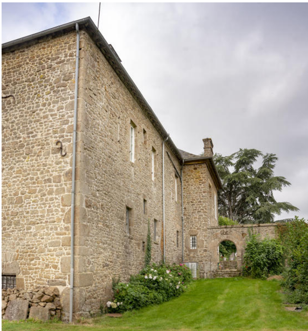
La façade postérieure du logis.
