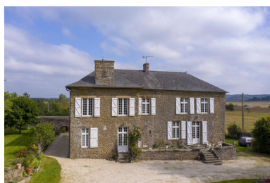
La façade antérieure du logis, depuis le sud. Phot. Pierre-Bernard Fourny IVR52_20215301084NUCA
