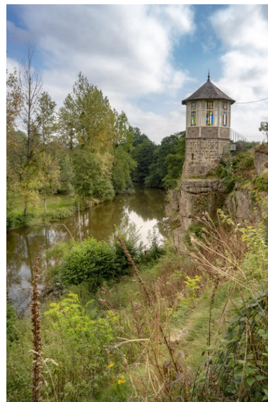
Le kiosque surplombant la Mayenne. Phot. Pierre-Bernard Fourny IVR52_20215301074NUCA
