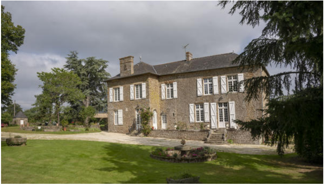
La façade antérieure du logis, depuis le sud-est.
