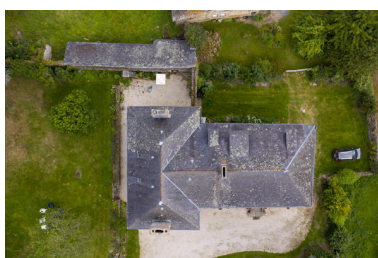
Une vue aérienne du logis. Phot. Pierre-Bernard Fourny IVR52_20215301070NUCA
