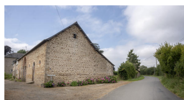
Les anciennes écuries. Phot. Pierre-Bernard Fourny IVR52_20215301075NUCA
