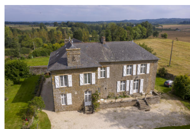
Une vue aérienne du logis. Phot. Pierre-Bernard Fourny IVR52_20215301083NUCA
