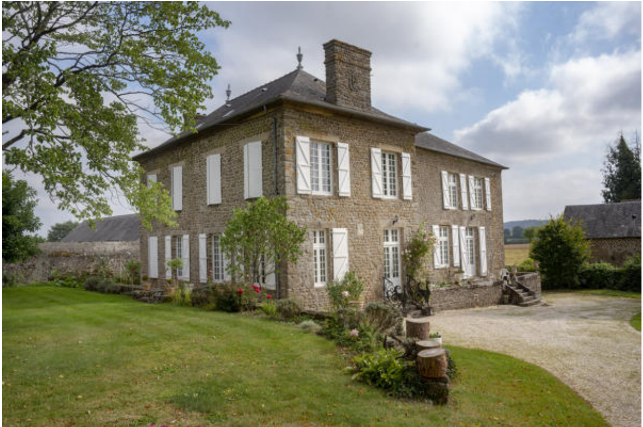
La façade latérale du logis, depuis le sud-est.
