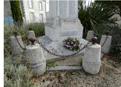
Les bornes et chaînes entourant le monument. Phot. Yannis Suire IVR52_20228500451NUCA
