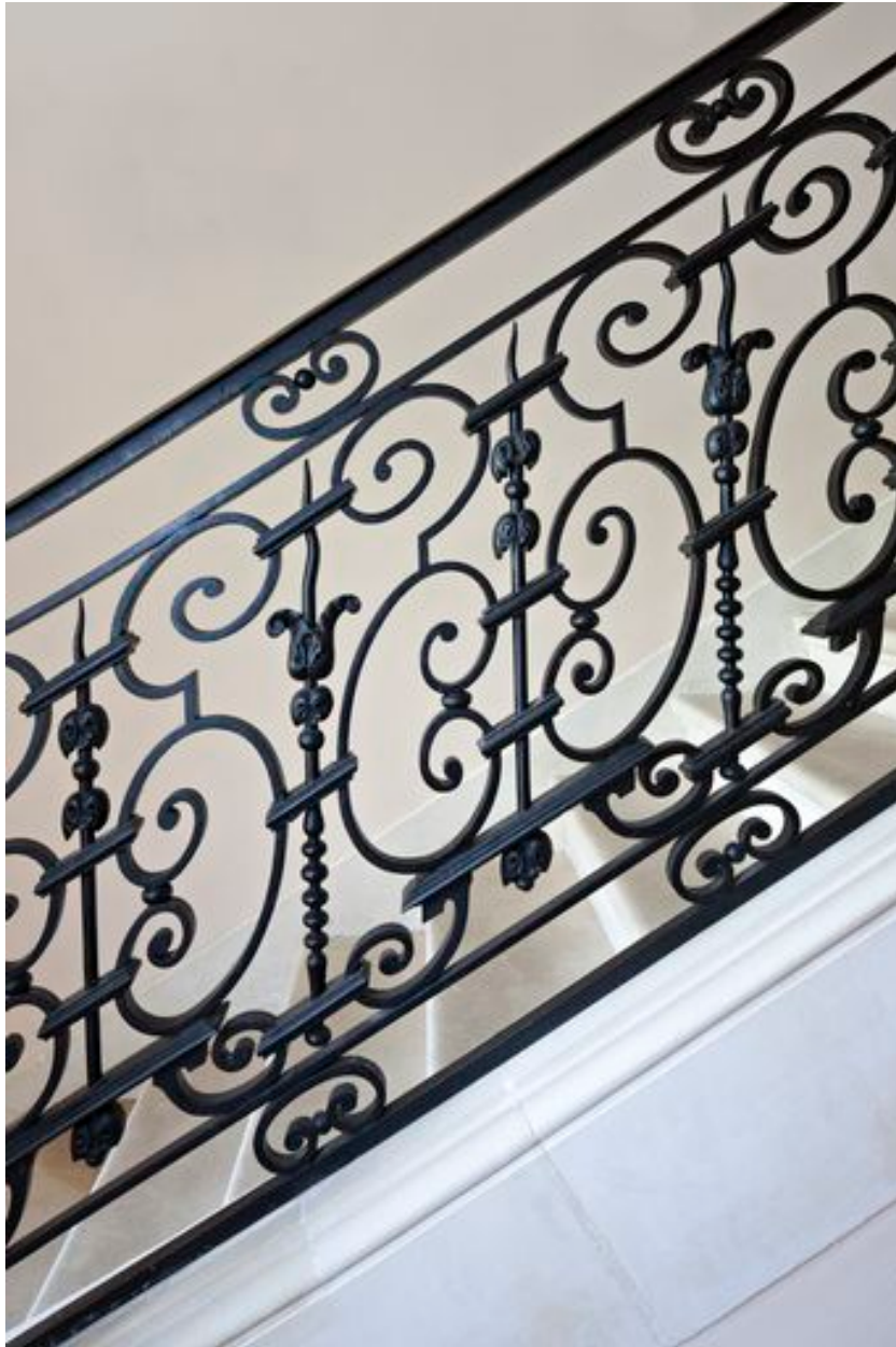
Détail de la rampe en fonte de l'escalier.
