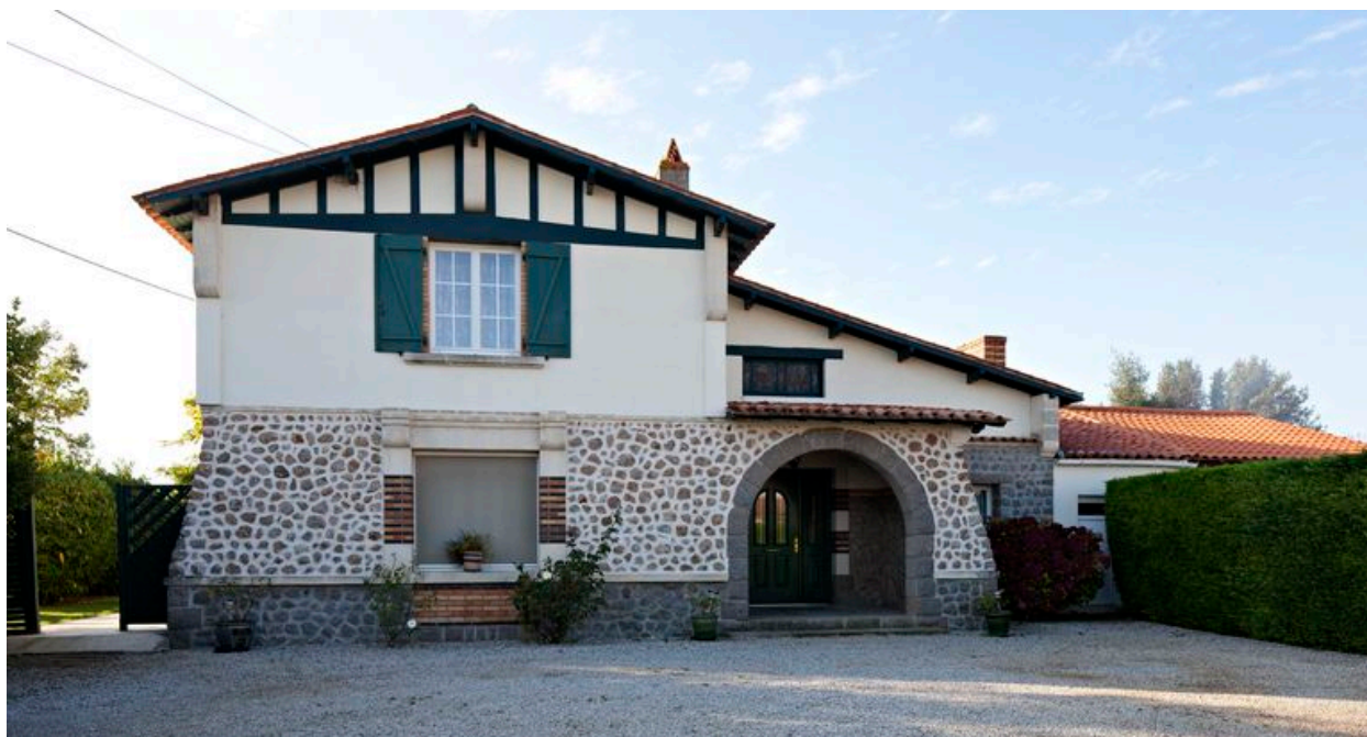
Façade est, du côté de l'entrée.
