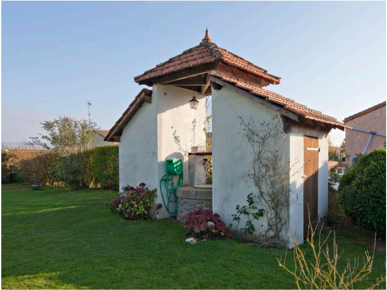
Vue du puits, situé dans le jardin.
