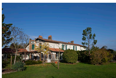
Vue de volume prise du sud-ouest du jardin. Phot. Patrice Giraud IVR52_20118500837NUCA
