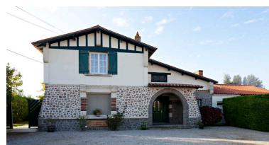
Façade est, du côté de l'entrée. Phot. Patrice Giraud IVR52_20118500839NUCA
