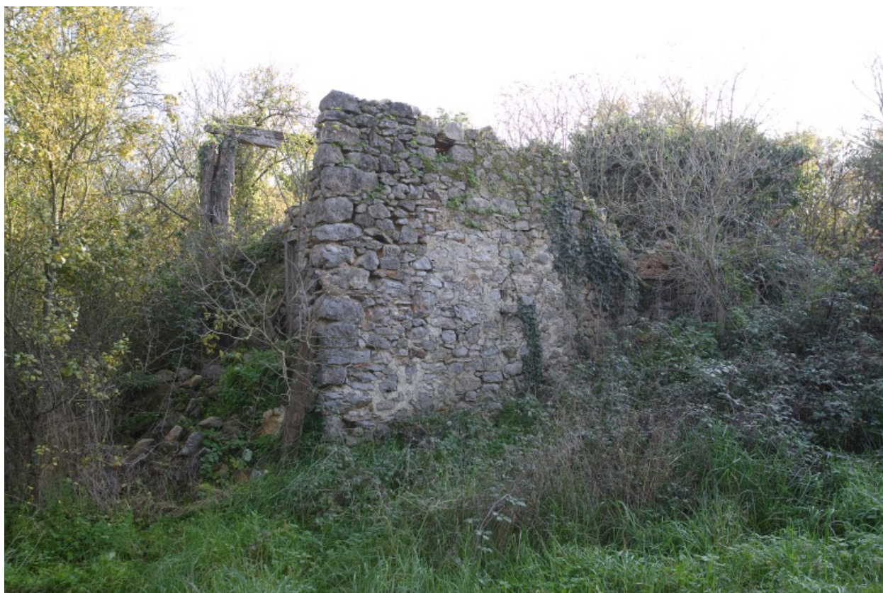
Les ruines du bâtiment situé au sud-ouest.
