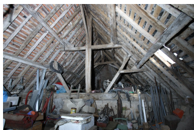
La charpente du logis. Phot. François Lasa IVR52_20065302692NUCA
