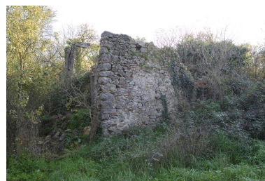
Les ruines du bâtiment situé au sud-ouest. Phot. François Lasa IVR52_20065302695NUCA
