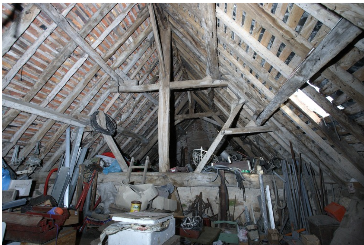
La charpente du logis.
