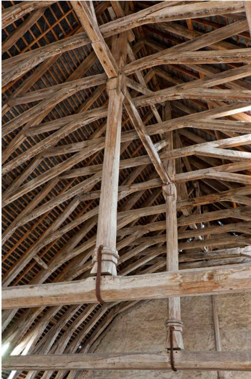
La charpente à chevrons-portant-ferme.
