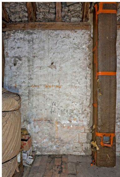
Mur nord, 1ère travée, détail : décor peint de lignes horizontales jaune et rouge. Phot. Yves Guillotin IVR52_20117200914NUCA
