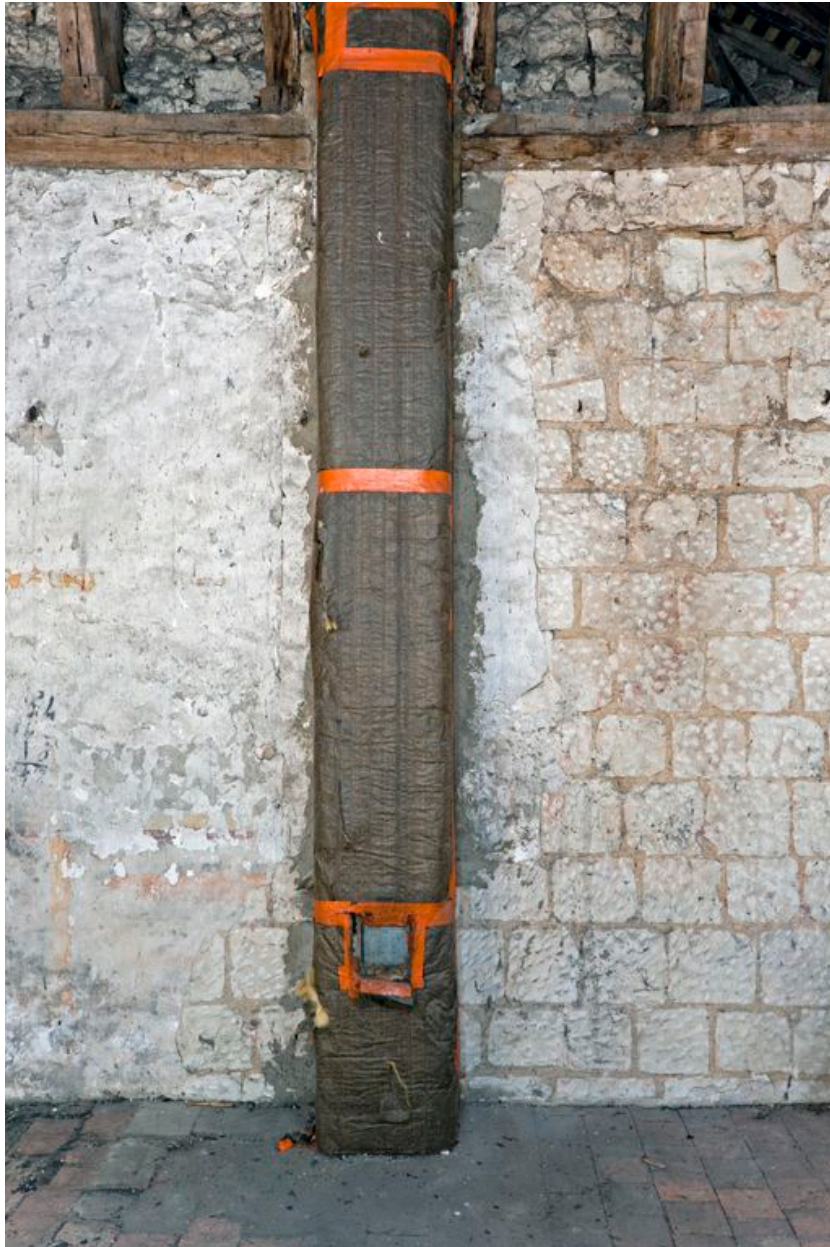
Mur nord, 1ère travée : la gaine passe devant une baie en plein cintre obstruée.
