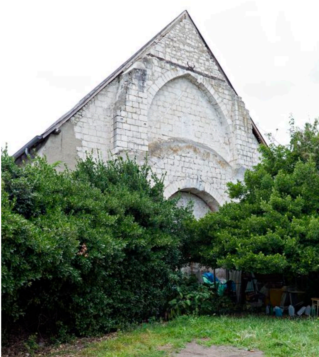
Mur de refend entre la nef et le choeur, pris de l'Est.
