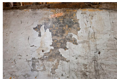
Mur sud, détail : fleurs de lys sur fond sombre. Phot. Yves Guillotin IVR52_20117200923NUCA
