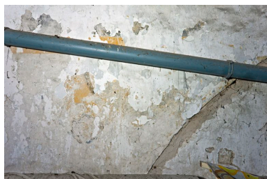
Arc diaphragme, détail. Phot. Yves Guillotin IVR52_20117200919NUCA
