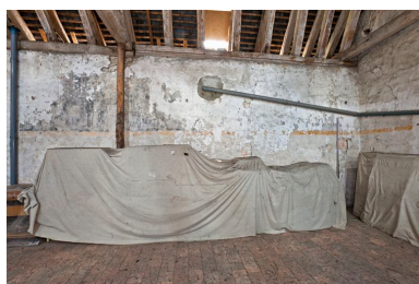
Angle nord-est de la nef : une bande jaune limite le registre supérieure orné de fleurs de lys. Le tout se retourne sur l'arc diaphragme. Phot. Yves Guillotin IVR52_20117200917NUCA
