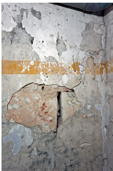
Angle nord-est, détail : trace de peinture sous l'enduit peint ? Phot. Yves Guillotin IVR52_20117200918NUCA
