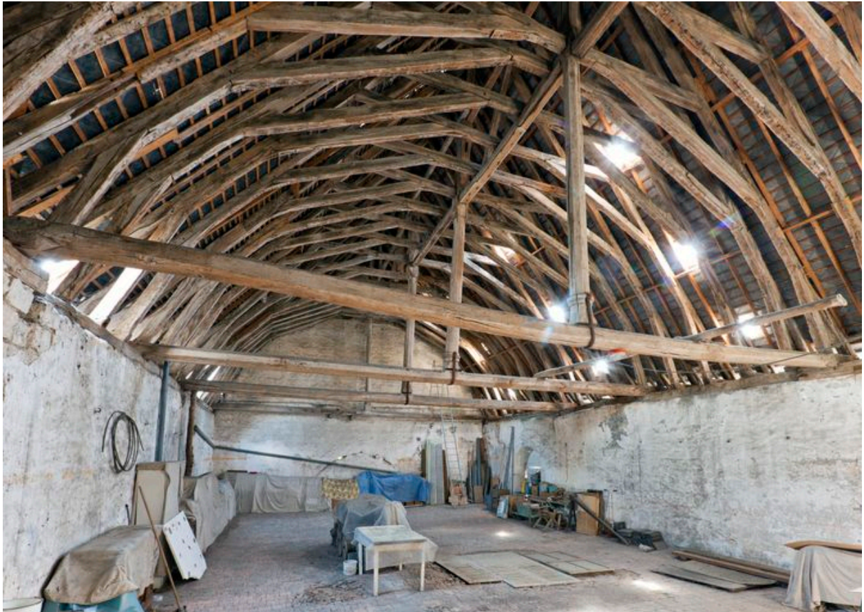
Charpente de la nef.
