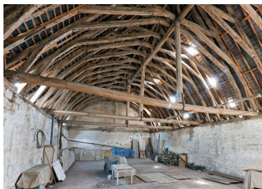
Charpente de la nef. Phot. Yves Guillotin IVR52_20117200908NUCA
