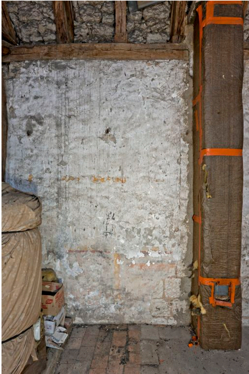
Mur nord, 1ère travée, détail : décor peint de lignes horizontales jaune et rouge.
