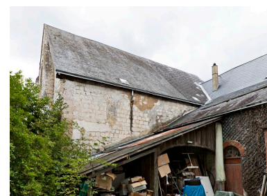
Mur nord de la nef. Phot. Yves Guillotin IVR52_20117200983NUCA
