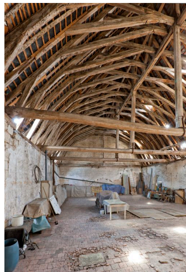
Charpente de la nef, vue prise de l'occident : pignon est avec la trace de l'arc diaphragme. Phot. Yves Guillotin IVR52_20117200909NUCA
