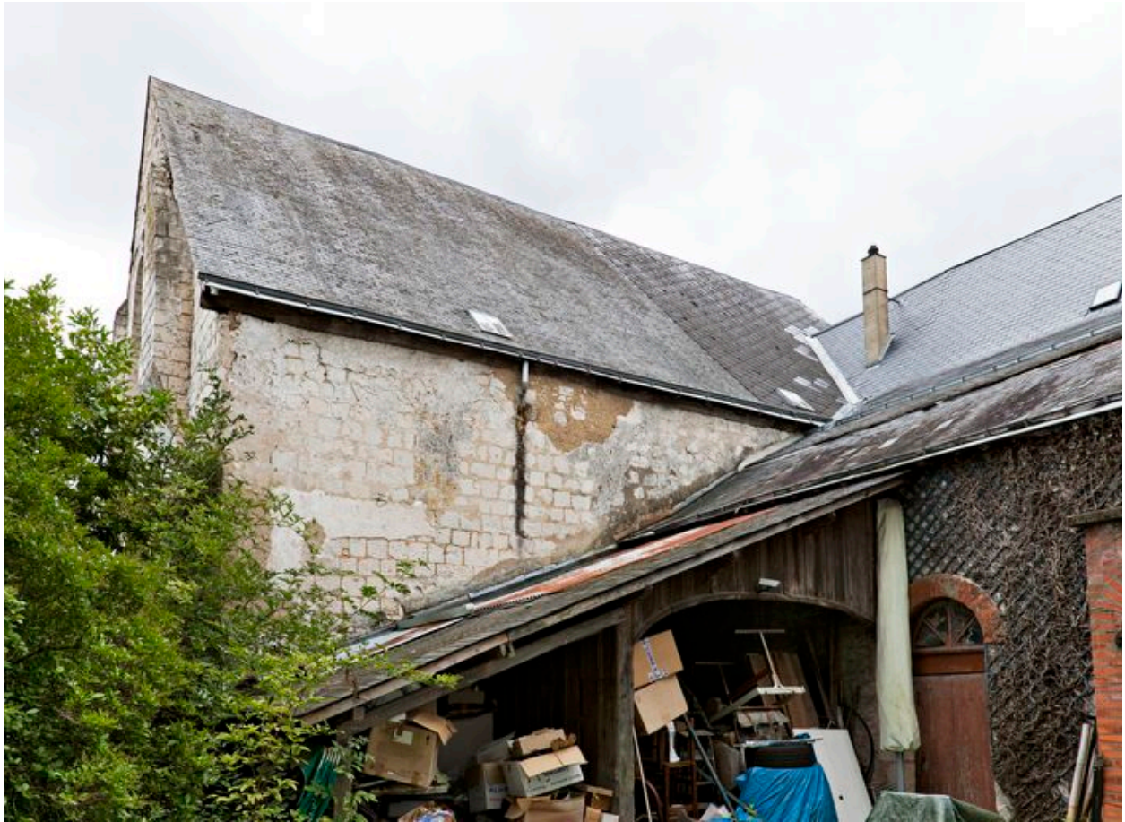
Mur nord de la nef.
