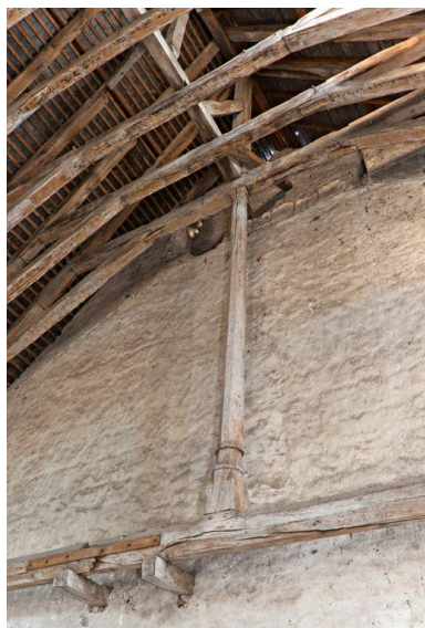
Pignon est de la nef : poinçon de la charpente et au-dessus, vestige d'un mur-clocher. Phot. Yves Guillotin IVR52_20117200911NUCA
