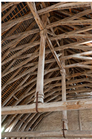
La charpente à chevrons-portant-ferme. Phot. Yves Guillotin IVR52_20117200912NUCA
