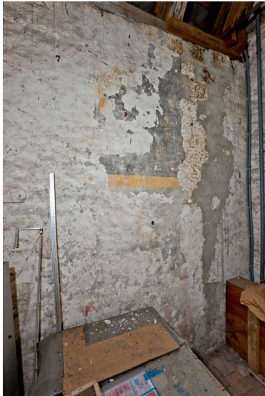
Angle sud-ouest de la nef. Phot. Yves Guillotin IVR52_20117200925NUCA
