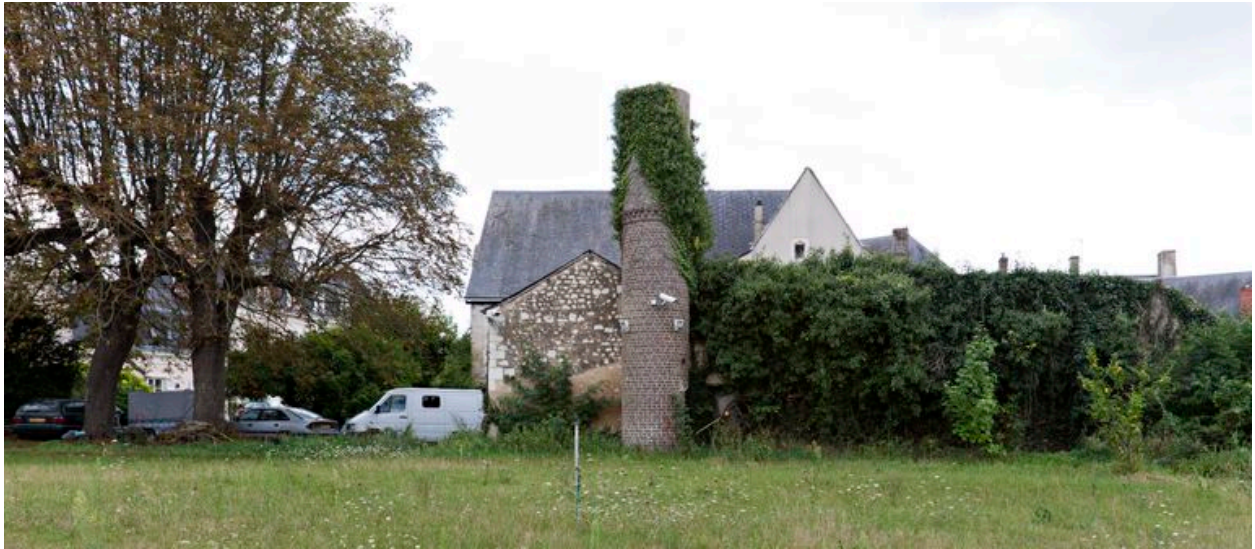
Vue d'ensemble prise du nord.
