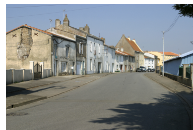
Vue du quai Chassagne vers l'aval. Phot. Denis Pillet IVR52_20034400242NUCA
