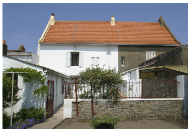
Vue partielle de la façade postérieure. Phot. Denis Pillet IVR52_20034400297NUCA
