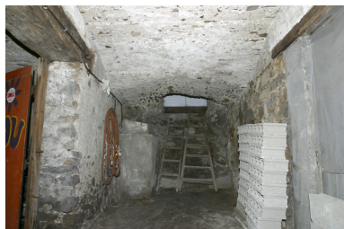
Le couloir situé entre les deux caves reliant anciennement la cour au sud à la Loire au Nord en passant sous le quai. Phot. Denis Pillet IVR52_20034400308NUCA
