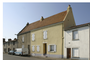
La façade antérieure, vue prise depuis la rue. Phot. Denis Pillet IVR52_20034400227NUCA
