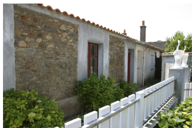
Maisons en apprentis parallèles au corps principal entre la cour et le jardin. Phot. Denis Pillet IVR52_20034400301NUCA
