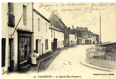
Vue d'ensemble vers l'aval : au centre, la maison dite Berg op zoom (1ère moitié XXe siècle). Autr. Artaud-Nozais, Phot. Denis (reproduction) Pillet IVR52_20034401796NUCA
