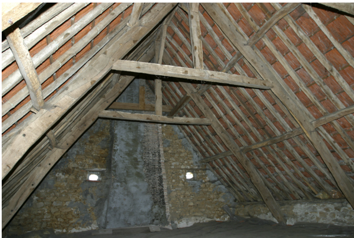
La charpente, vue prise vers le pignon ouest.
