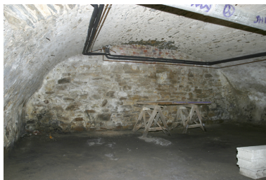
La cave voûtée située à l'ouest du couloir central. Phot. Denis Pillet IVR52_20034400310NUCA
