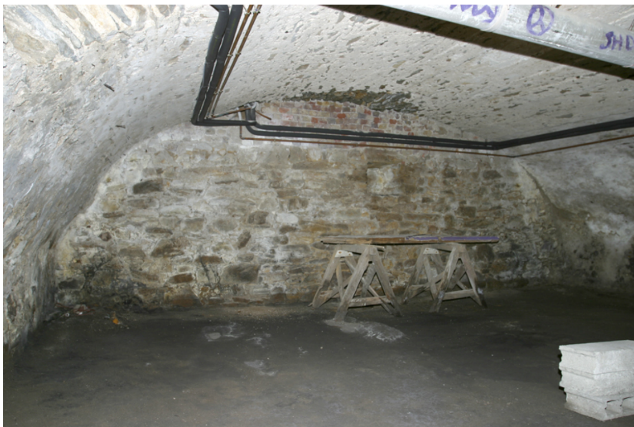
La cave voûtée située à l'ouest du couloir central.
