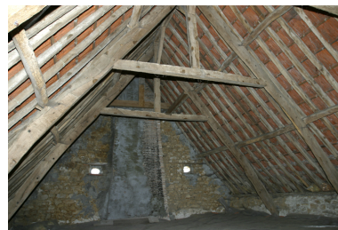
La charpente, vue prise vers le pignon ouest. Phot. Denis Pillet IVR52_20034400304NUCA
