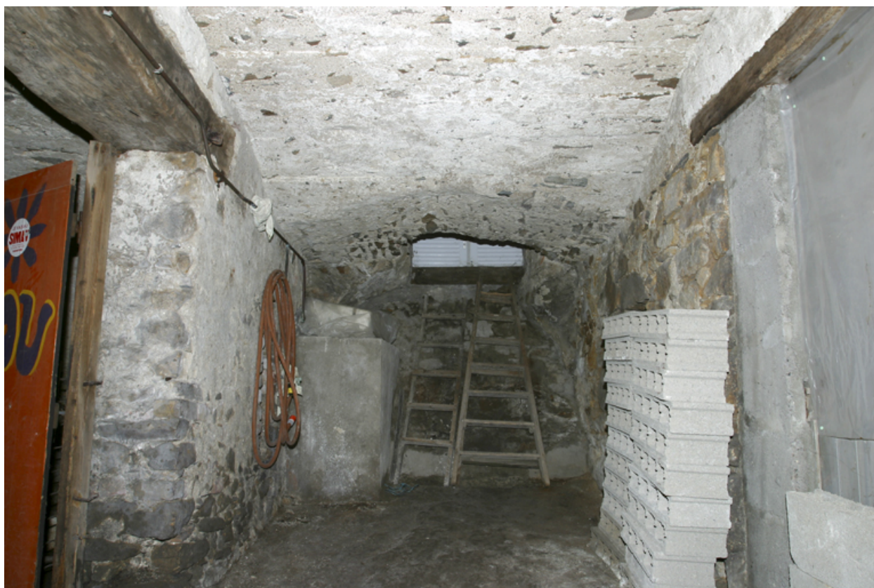
Le couloir situé entre les deux caves reliant anciennement la cour au sud à la Loire au Nord en passant sous le quai.
