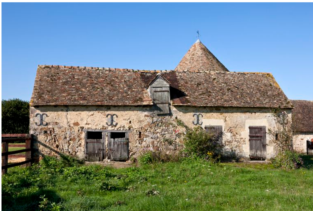
Elévation sur cour des étables.
