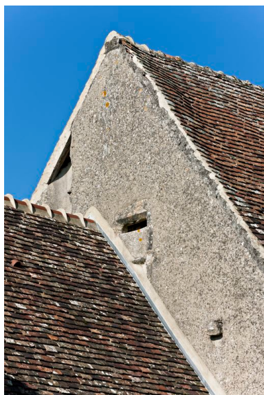
Pignon droit du corps principal du logis : demie-croisée et vestige du conduit de cheminée cylindrique, limite des XVe et XVIe siècles. Phot. Yves Guillotin IVR52_20137200673NUCA
