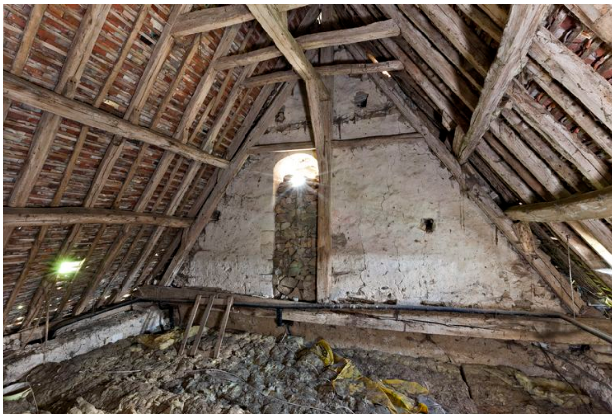
Vue intérieure de la demie-croisée du pignon droit du logis.
