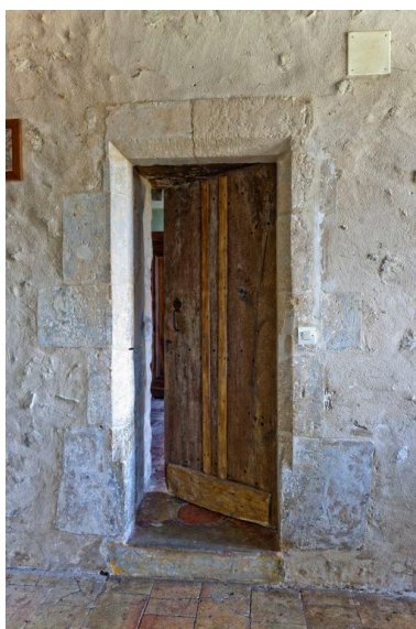
Porte de communication vers le corps accolé au pignon droit. Phot. Yves Guillotin IVR52_20137200677NUCA
