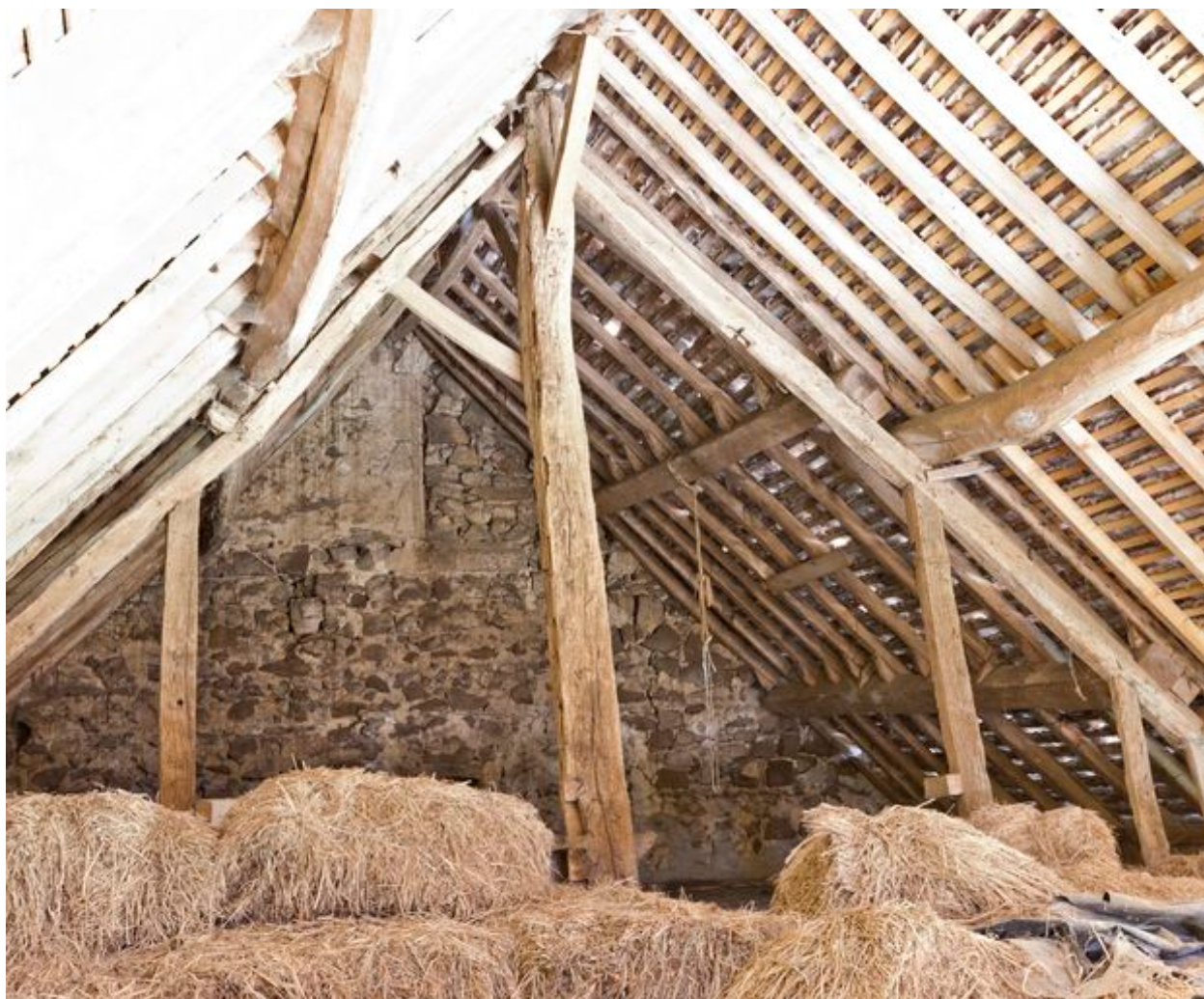
Partie basse de la fenêtre bouchée, vue depuis le comble de la remise.
