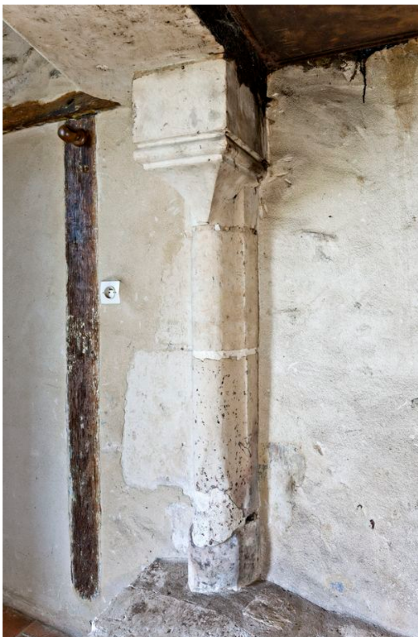
Piédroit gauche de la cheminée.
