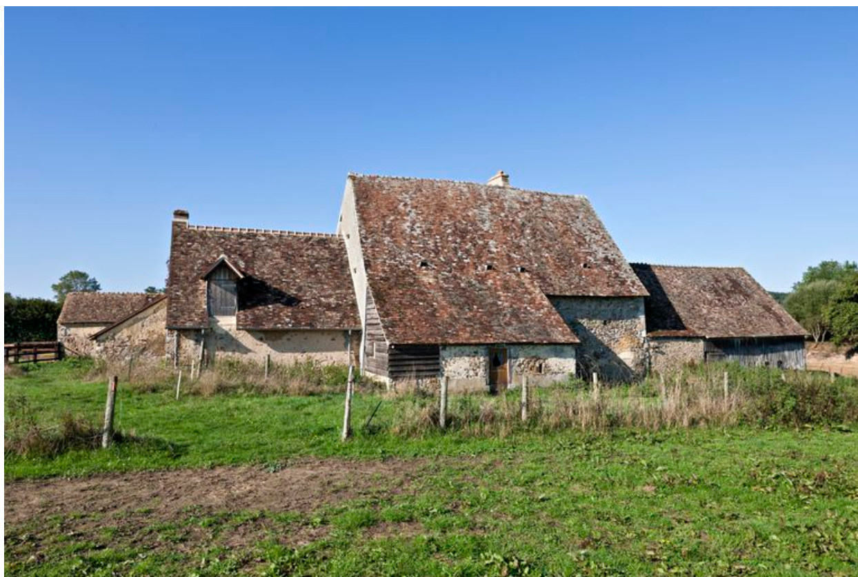
Elevations postérieures du logis.
