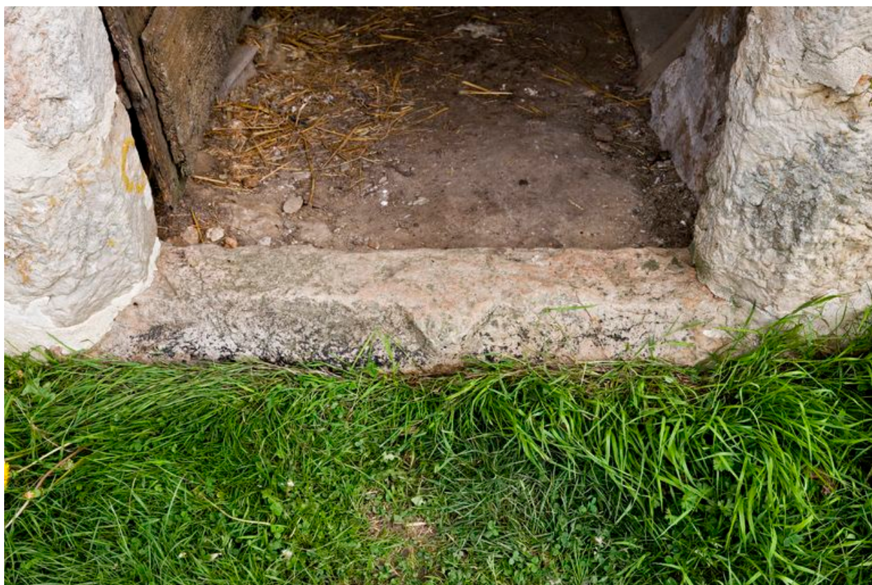
Détail de la porte : élément de baie à traverse réemployé au seuil.
