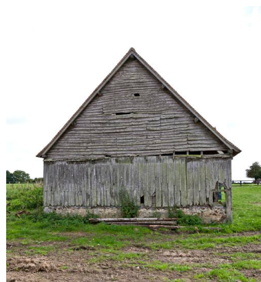
Pignon gauche de la remise accolée au logis. Phot. Yves Guillotin IVR52_20137200691NUCA
