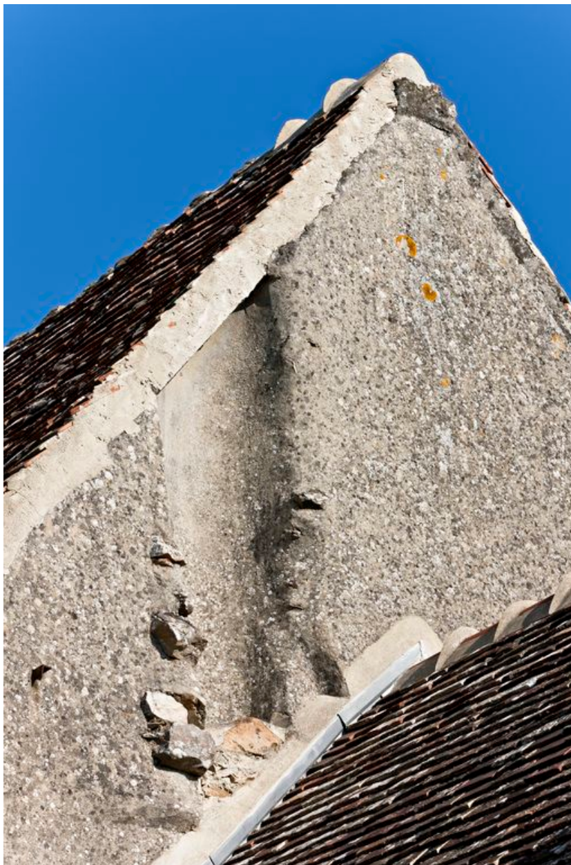
Détail du vestige d'un conduit de cheminée cylindrique.
