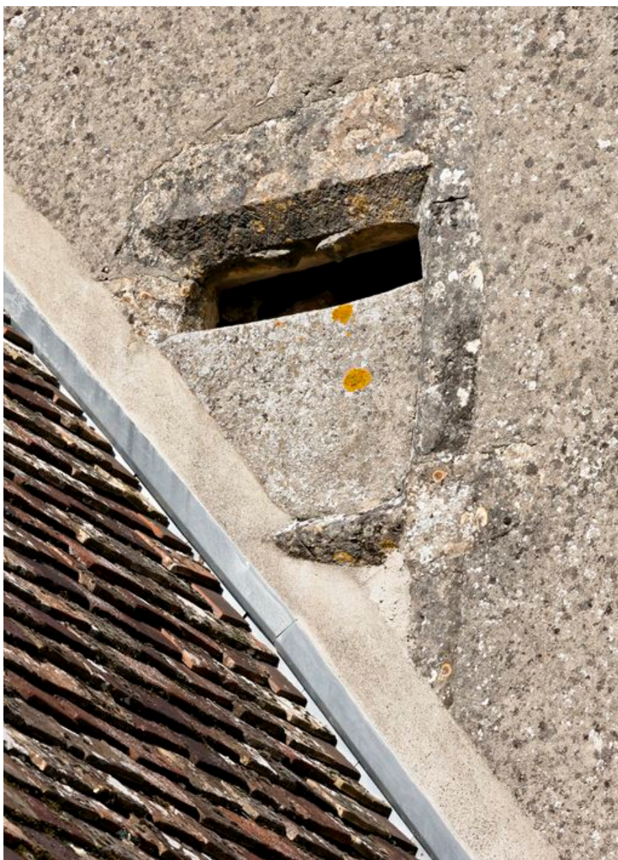
Détail de la demie-croisée.
