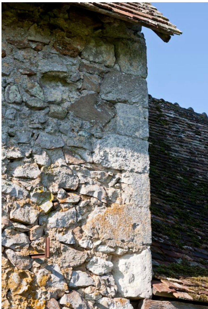
Détail de la chaîne d'angle droite en calcaire de l'élévation postérieure du corps principal du logis.
