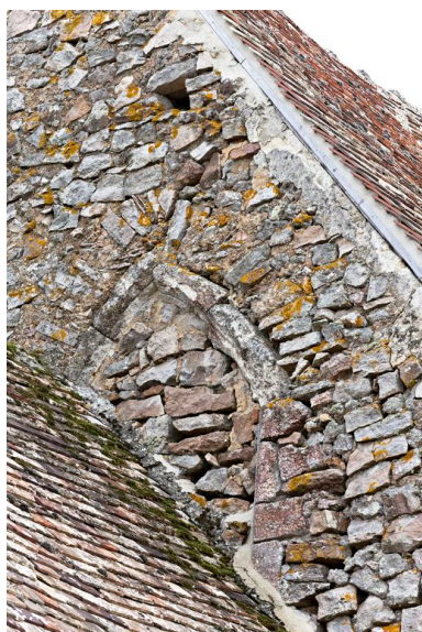
Détail de la fenêtre bouchée du pignon gauche du logis, limite des XIVe et XVe siècles.
