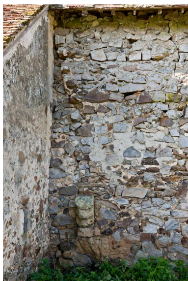
Vestige de la cheminée du corps disparu, recoupée par le mur de la laiterie. Limite des XIVe et XVe siècles. Phot. Yves Guillotin IVR52_20137200663NUCA
