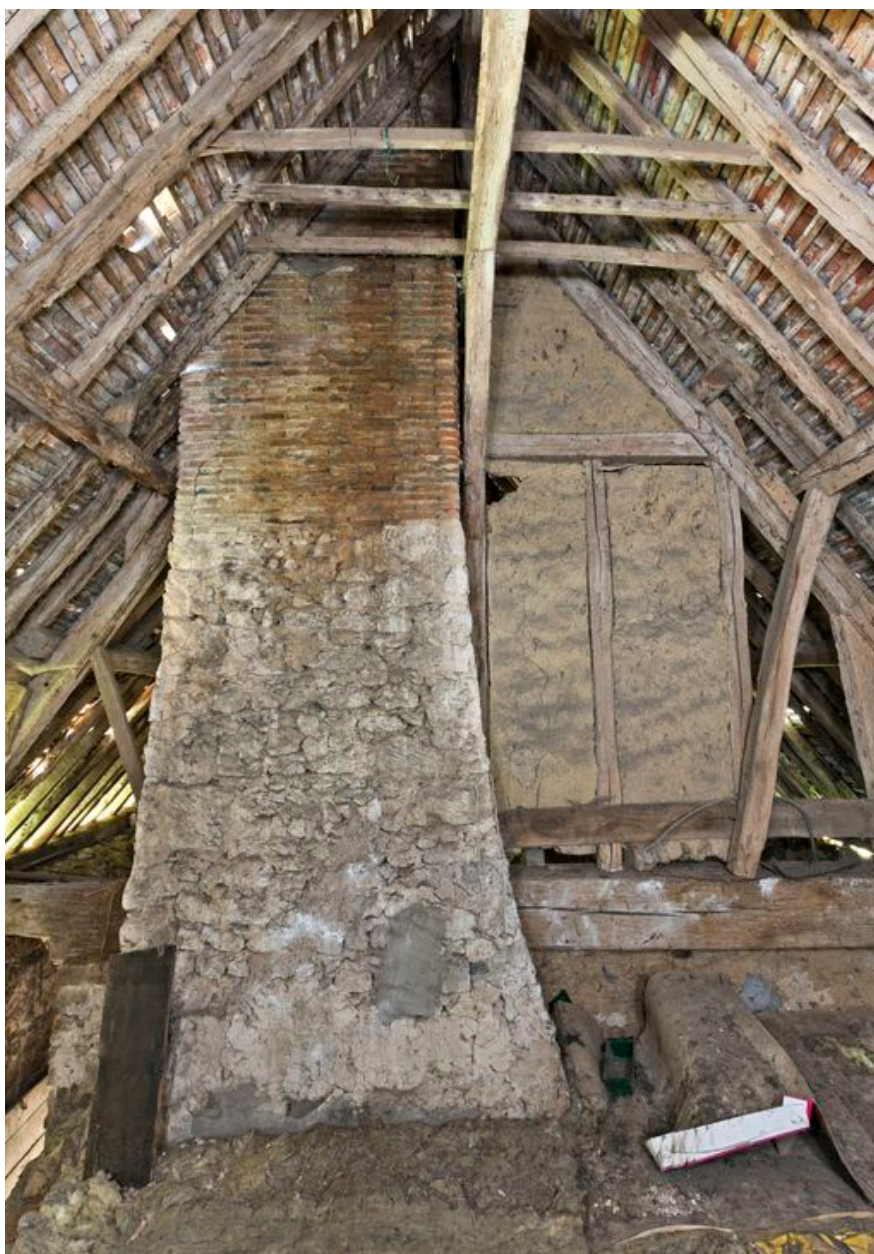
Conduit de la cheminée adossée au refend du corps principal du logis
