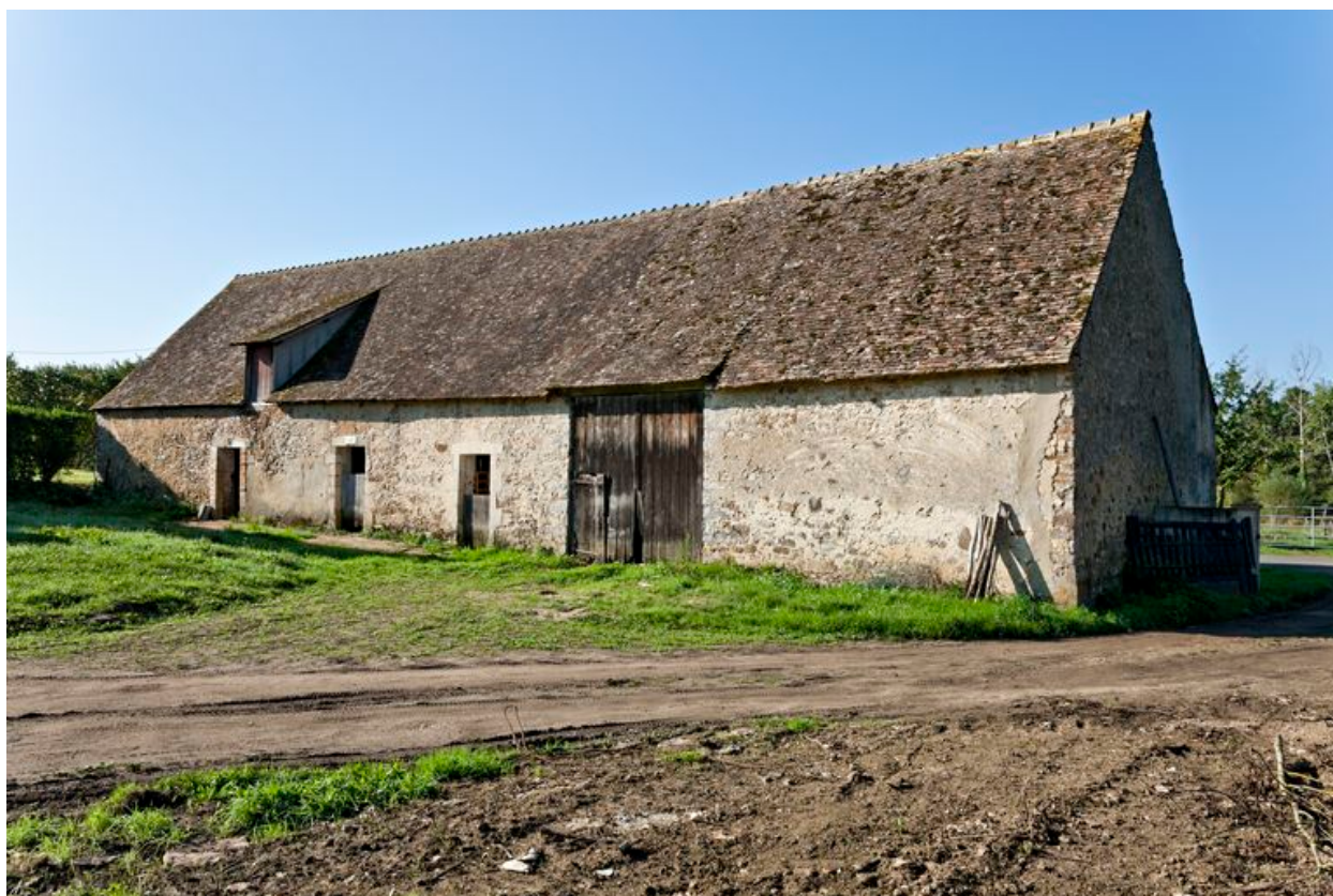
Elévation sur cour de la grange-étable-fenil.
