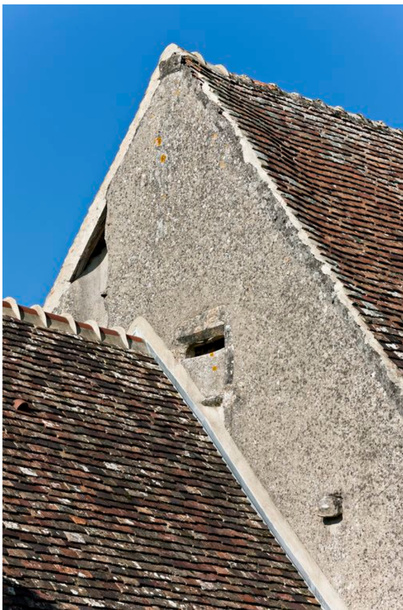
Pignon droit du corps principal du logis : demie-croisée et vestige du conduit de cheminée cylindrique, limite des XIVe et XVe siècles.
