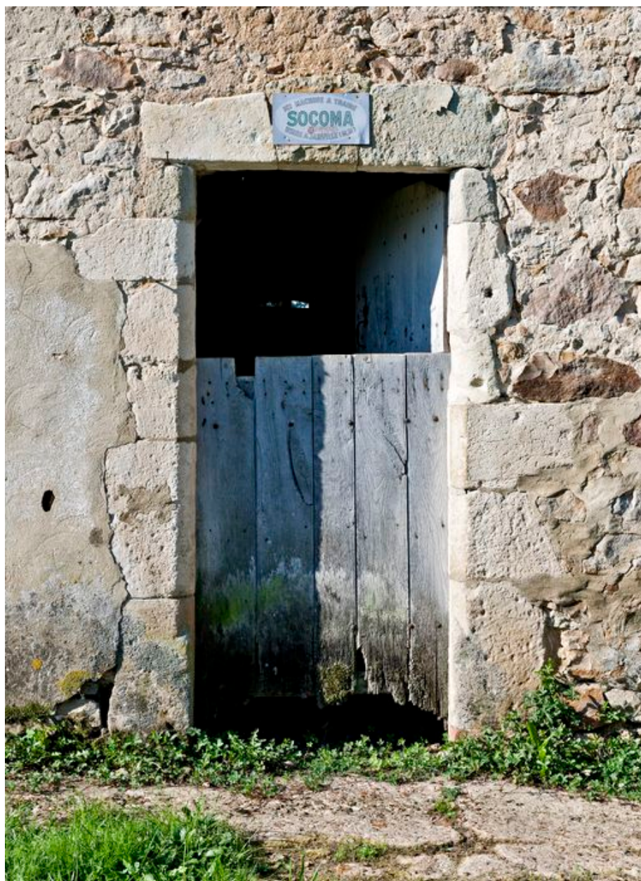
Porte centrale de la grange-étable-fenil.
