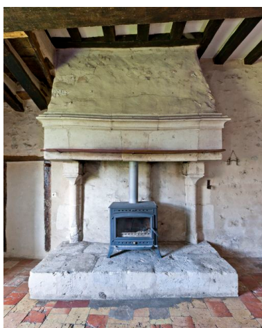
Cheminée du corps principal du logis, 2e moitié du XVe siècle. Phot. Yves Guillotin IVR52_20137200674NUCA
