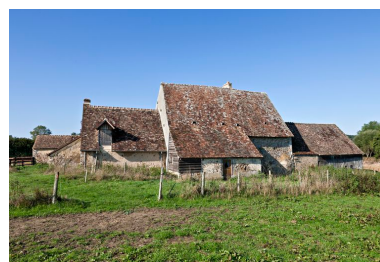
Elevations postérieures du logis.
