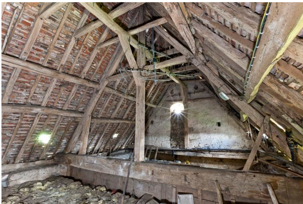
Vue intérieure du comble du corps principal.
