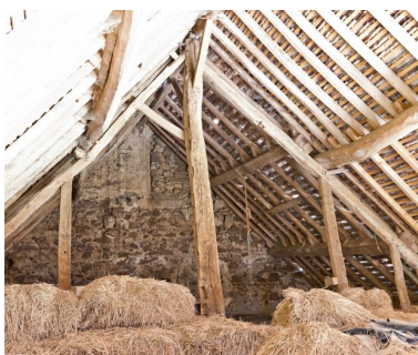
Partie basse de la fenêtre bouchée, vue depuis le comble de la remise.
