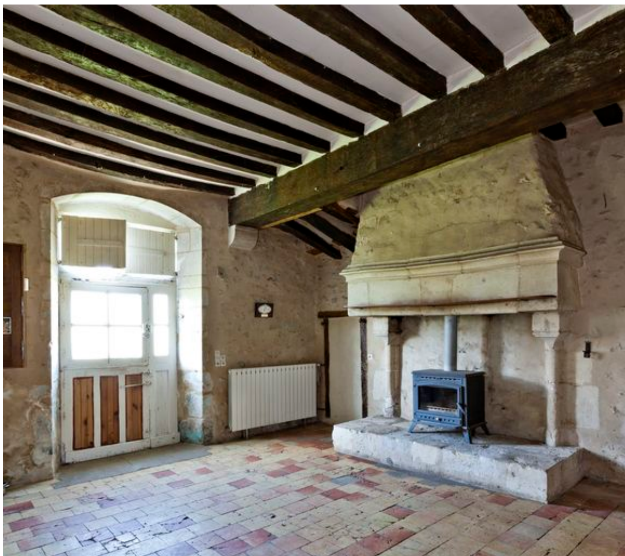
Vue intérieure du corps principal du logis.
