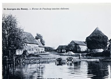
Vue générale dans la 1ère moitié du XXe siècle. A noter l'état ancien de la fenêtre du logis. Autr. J. Bouveret, Phot. Yves Guillotin IVR52_20147201780NUCAB
