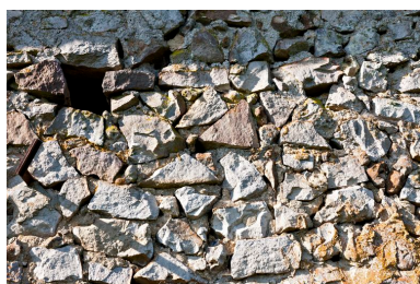
Détail de la maçonnerie en moellons de grès de l'élévation postérieure du corps principal du logis.
