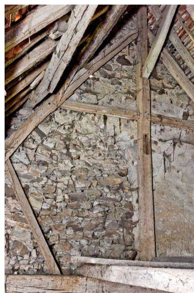
Vue intérieure de la fenêtre du pignon gauche du logis. Phot. Yves Guillotin IVR52_20137200684NUCA
