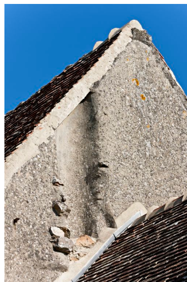
Détail du vestige d'un conduit de cheminée cylindrique. Phot. Yves Guillotin IVR52_20137200671NUCA
