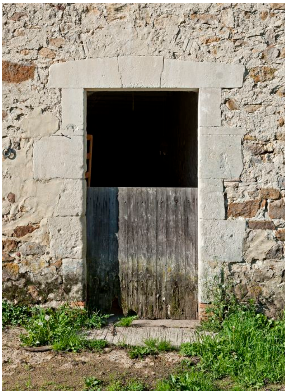
Porte droite des étables de la grange-étables-fenil.
