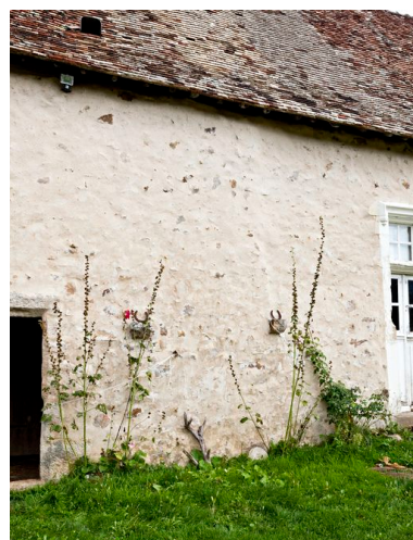
Détail de l'élévation sur cour du logis. Phot. Yves Guillotin IVR52_20137200688NUCA
