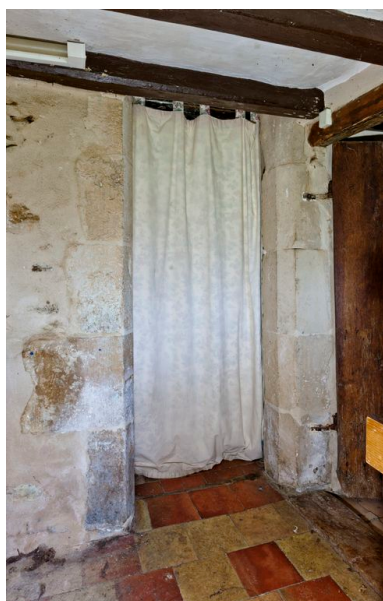
Ancienne porte de communication vers le corps adossé à l'élévation postérieure, donnant actuellement dans l'ancienne laiterie. Phot. Yves Guillotin IVR52_20137200678NUCA
