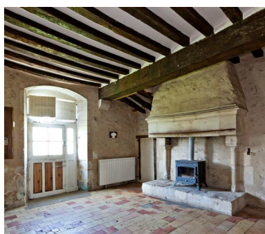
Vue intérieure du corps principal du logis. Phot. Yves Guillotin IVR52_20137200676NUCA
