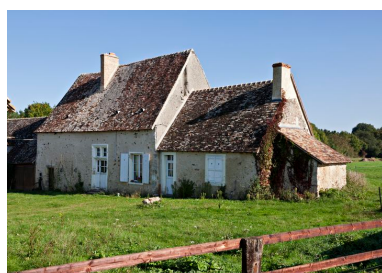
Elévations sur cour du logis. Phot. Yves Guillotin IVR52_20137200670NUCA
