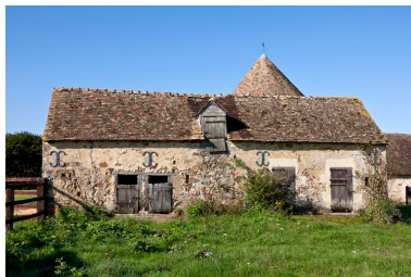
Elévation sur cour des étables. Phot. Yves Guillotin IVR52_20137200660NUCA
