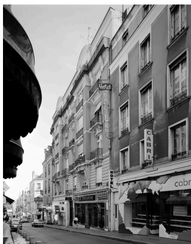
Elévation antérieure. Phot. François Lasa IVR52_19904900547V
