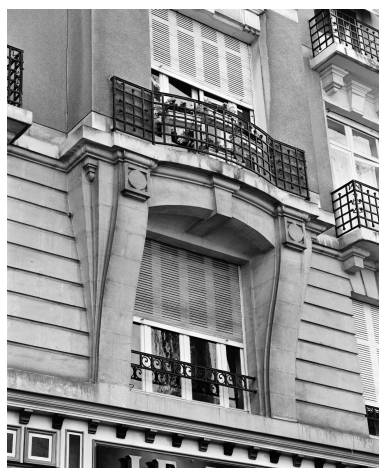
Elévation antérieure, avant-corps droit : baies des 2e et 3e niveaux. Phot. François Lasa IVR52_19904900556X
