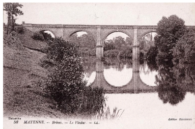
Vue d'ensemble depuis la rive gauche en amont Autr. Rousseau, Autr. Léon et Lévy, Repro. François Lasa IVR52_20065300832NUCA
