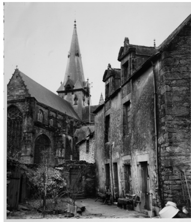
Cliché de la maison avant reconstruction. Phot. Denis (reproduction) Pillet IVR52_20074401045NUCA
